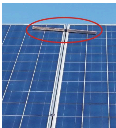
Obrázek 11 Nesprávné uchycení panelu
