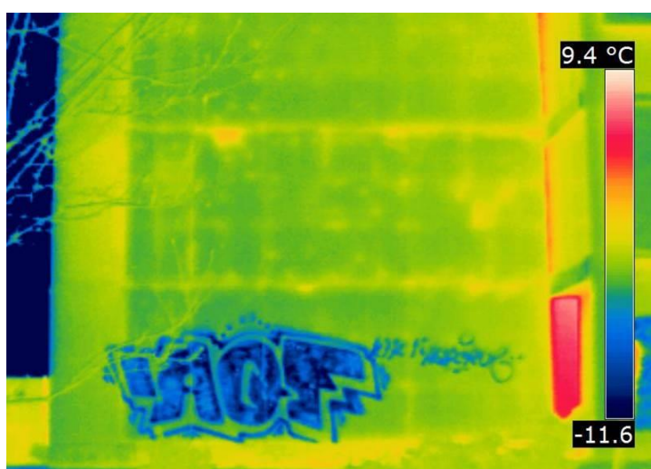
Obrázek 20: Termogram fasády domu (autor Centrum termografie)
