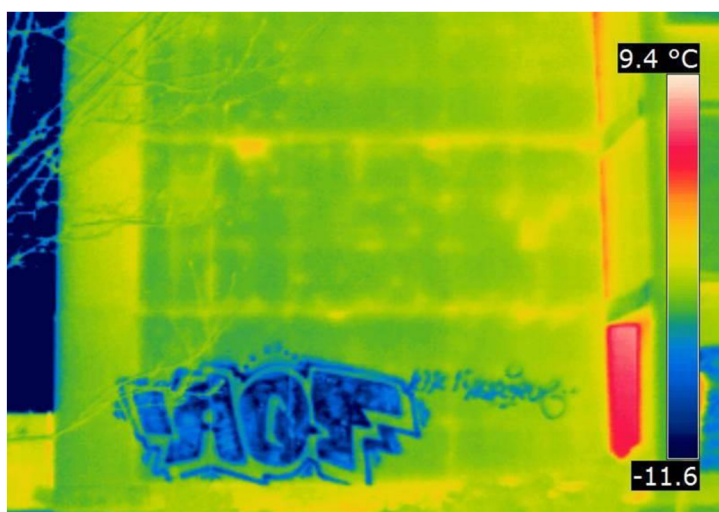
Obrázek 20: Termogram fasády domu (autor Centrum termografie)
