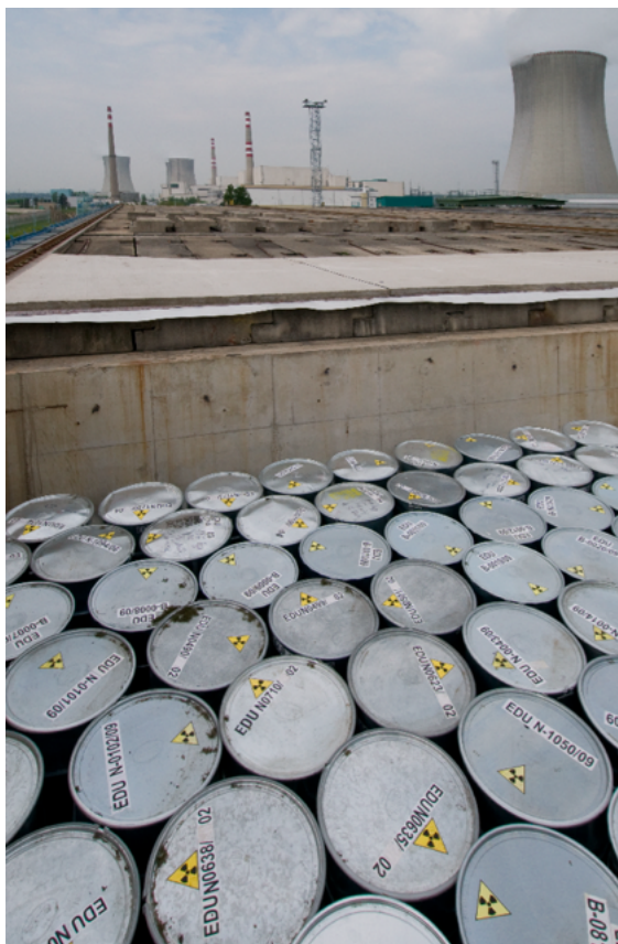
Obr. 1.1: Jímka se sudy v úložišti Dukovany.[6]
