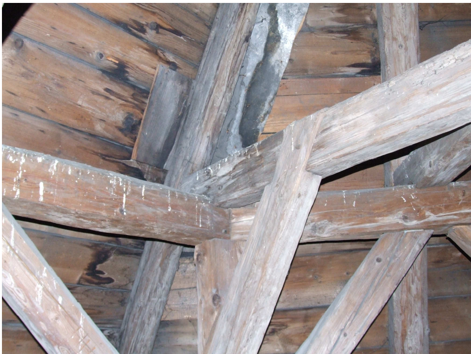
Obr. 20: Detail krovu presbytáře
