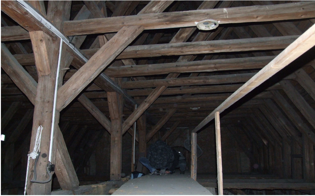
Obr. 17: Hambalkový krov se stojatou stolicí (pohled od presbytáře)
