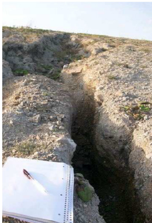
Obr. 4-1 Eroze břehových svahů zbytkové jámy Medard-Libík
