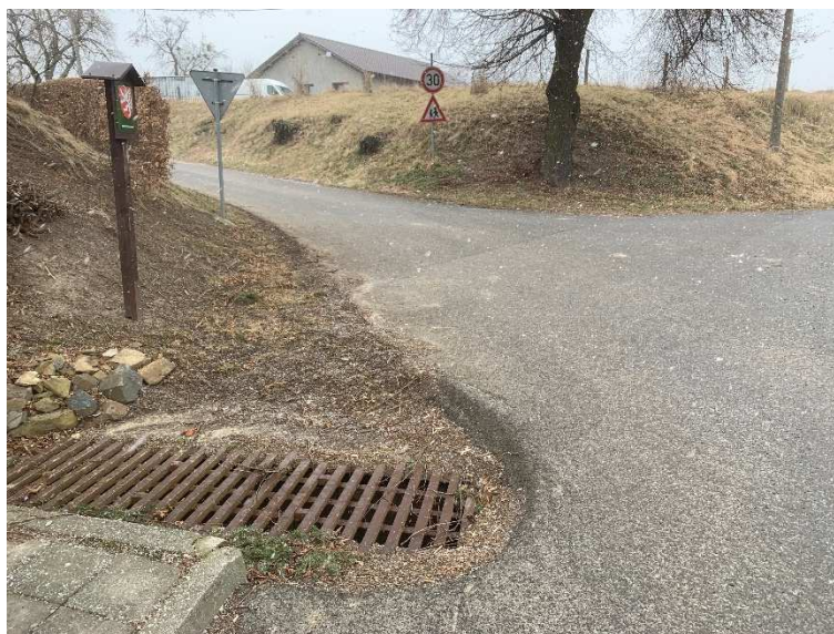
Obr. 46 Záchytný žlab
