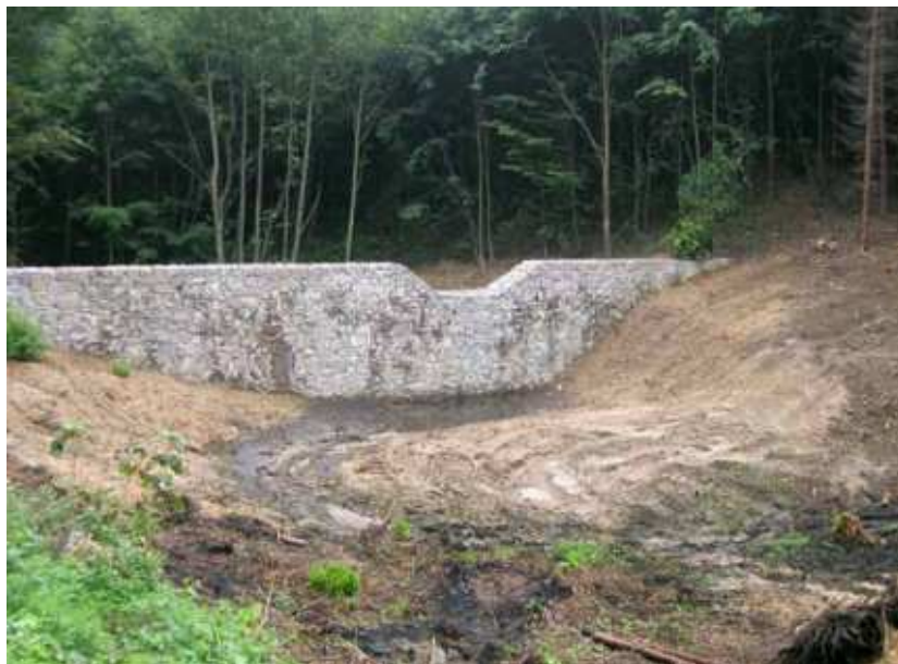
Obr. 53 Příklad kamenné zděné přehrážky [32]
