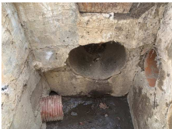
Obr. 44 Šachta, do které vtékají srážky potrubím s DN 500 – toto potrubí svádí srážky z KP3. Srážky dále odtékají potrubím s DN 600 do přilehlé řeky Libušky
