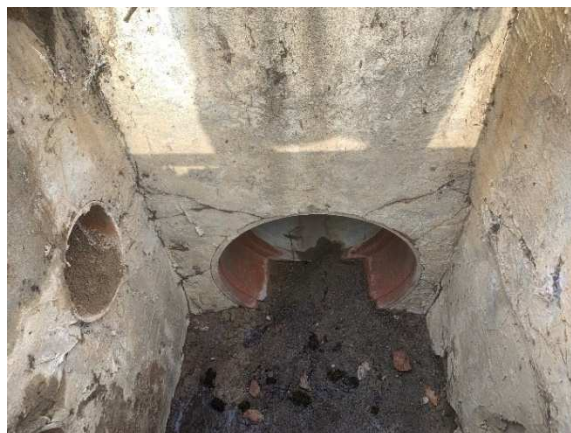
Obr. 44 Šachta, do které vtékají srážky potrubím s DN 500 – toto potrubí svádí srážky z KP3. Srážky dále odtékají potrubím s DN 600 do přilehlé řeky Libušky
