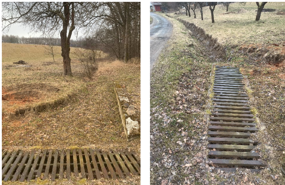
Obr. 42 Záchytný žlab a záchytný příkop s rozměry b = 600 \text{ mm} , B = 1700 \text{ mm} a h = 800 \text{ mm} v místě KB3
