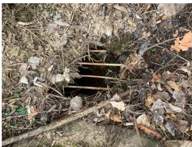
Obr. 39 Krytí propustku umístěného u místní komunikace
