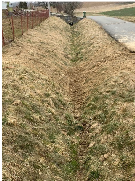
Obr. 28 Svodný příkop v místě KB1 s rozměry b= 900 \text{ mm} B= 1600 \text{ mm} h= 550 \text{ mm}
