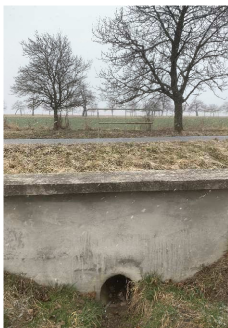
Obr. 33 Propustek pod komunikací rozšiřující území KP1
