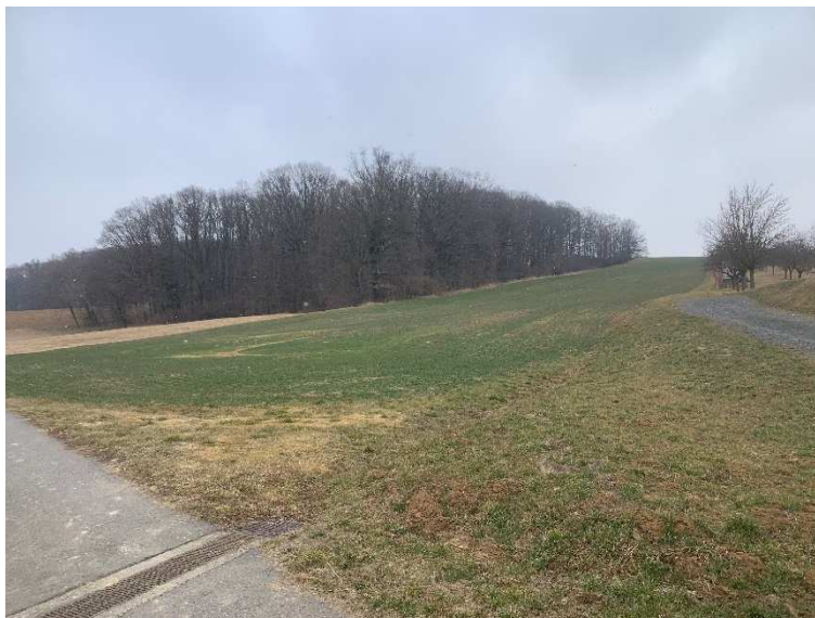
Obr. 30 Přispívající plocha levé části KP1 a žlab svádějící srážky do svodného příkopu
