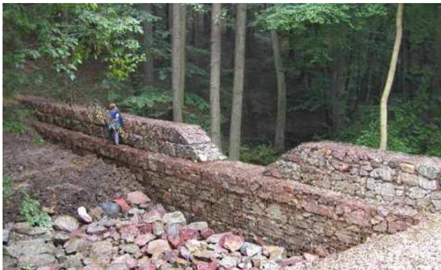
Obr. 56 Příklad drátokamenné přehrážky [32]
