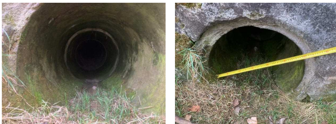
Obr. 29 Potrubí DN 600
