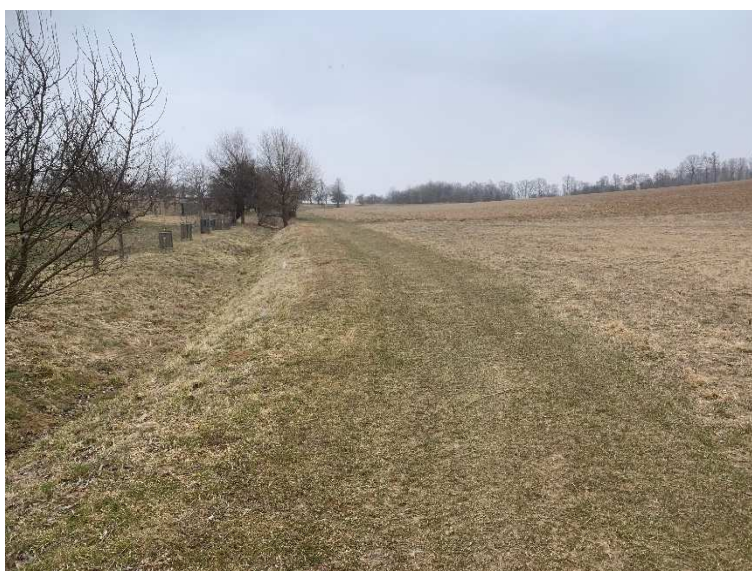
Obr. 31 Přispívající plocha levé části KP1, včetně svodného příkopu
