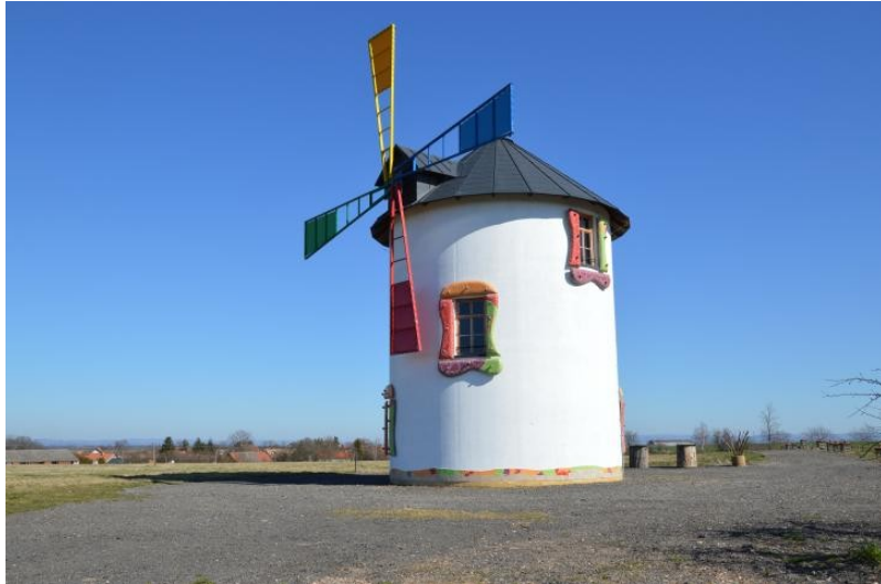
Obr. 22: Černilov. Novostavba nefunkčního větrného mlýna z roku 2016. Převzato: hkregion.cz
