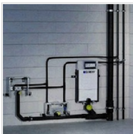
Obr. 22 Připojovací potrubí pro upevnění závěsných zařizovacích předmětů [9]
