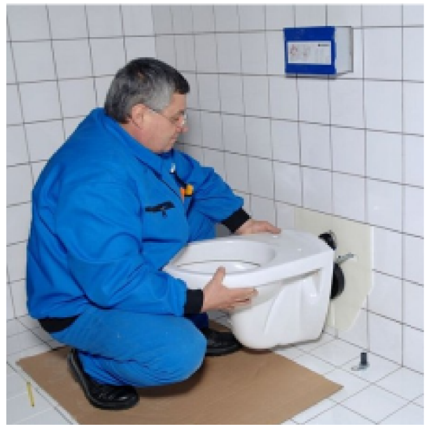
Obr. 24 Geberit Kombifix obložený a Přidělování závěsné záchodové mísy [9]
