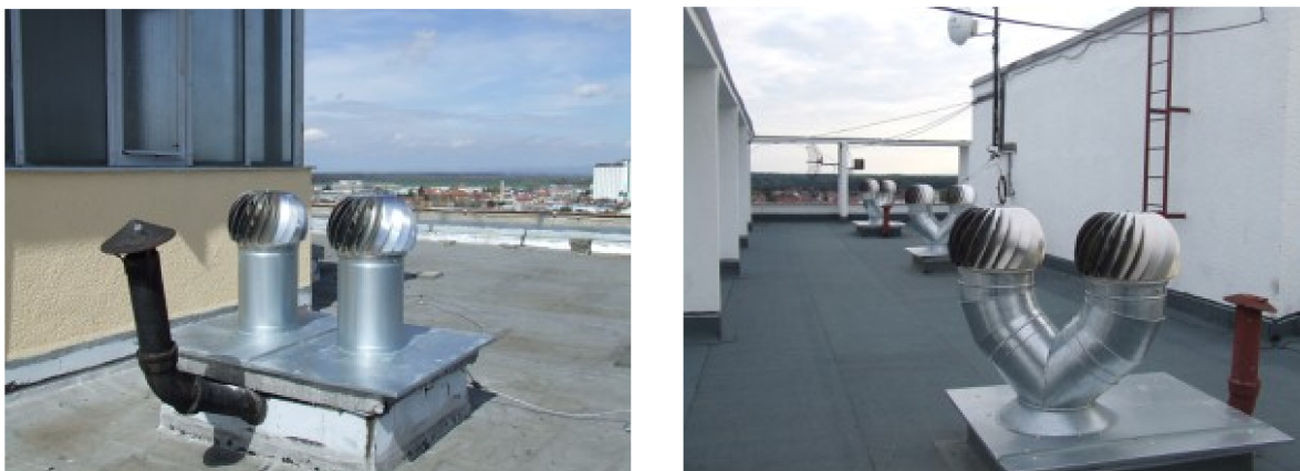
Obr. 21 příklady ventilační turbíny a hybridního ventilátoru [7]
