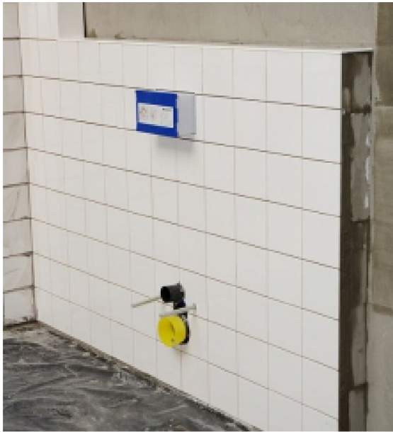
Obr. 24 Geberit Kombifix obložený a Přidělování závěsné záchodové mísy [9]
