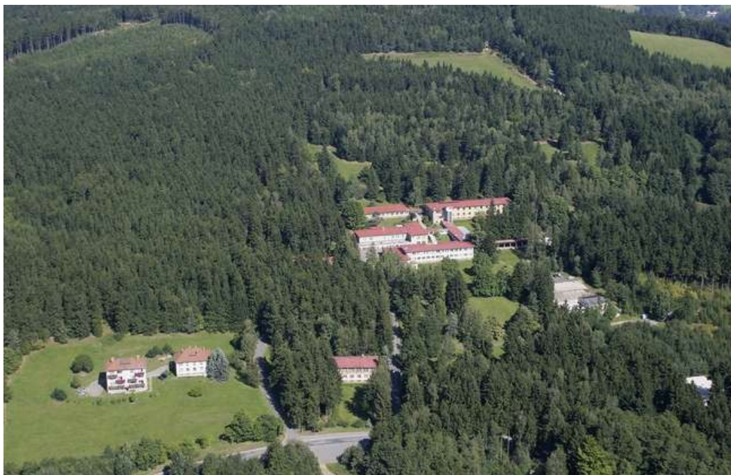
Fotografie č.13 , narušení lesní složky krajinného rázu - budovy léčebny na Buchtově kopci, dole vlevo bytovky městského typu ve volné krajině (Zdroj: letecké fotografie Městys Sněžné 2008)
