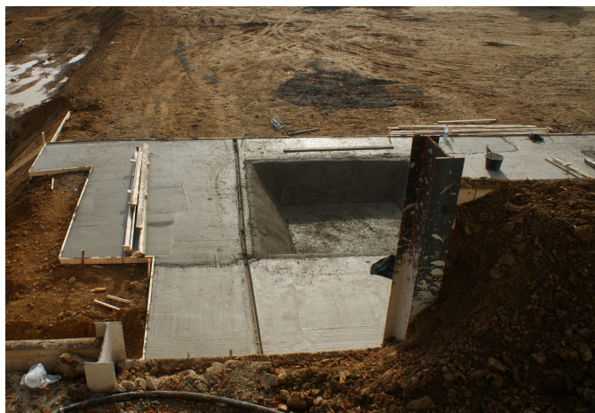
Obrázok 66: Ilustračná foto - realizácia vrstvy podkladného betónu [vlastná tvorba autora]
