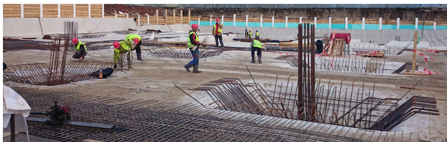
Obrázok 67: Ilustračná foto - konštrukcia základovej dosky 1.PP [vlastná tvorba autora]
