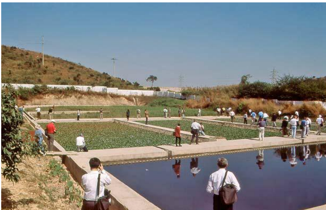
Obrázek 3 Kombinovaný systém v čínském Yantianu pro společné čištění městských splašků a průmyslových odpadních vod ( foto Vymazal ).
