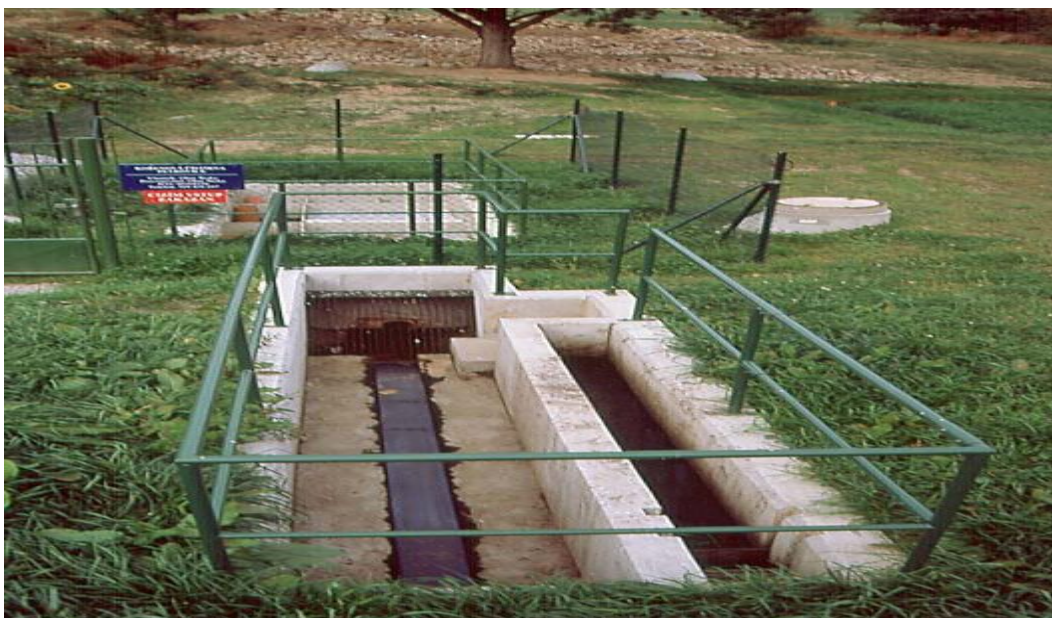
Obrázek 8 Lapák písku, česle a štěrbinová nádrž na KČOV Petrovice u Havl.Brodu ( foto Vymazal )
