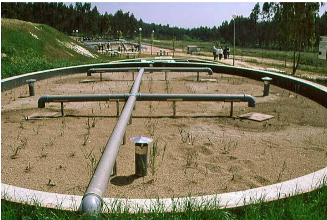
Obrázek 2 Umělý mokřad s vertikálním průtokem – součást kombinovaného systému pro čištění průsaků ze skládky odpadu v Portugalsku (foto Vymazal)
