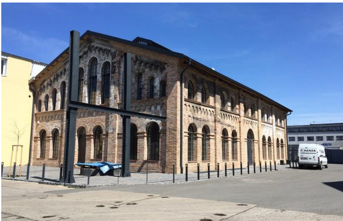
Obrázek č. 43 – Strojovna po rekonstrukci. Zdroj: www.arxstudio.cz/kladno-vojteska-hut . [2019.03.27.]
