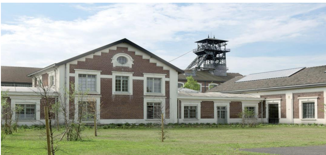
Obrázek č. 12 - Důlní budova s těžní věží, Oignies, Francie. Zdroj: URL 5. [2019.03.17]
