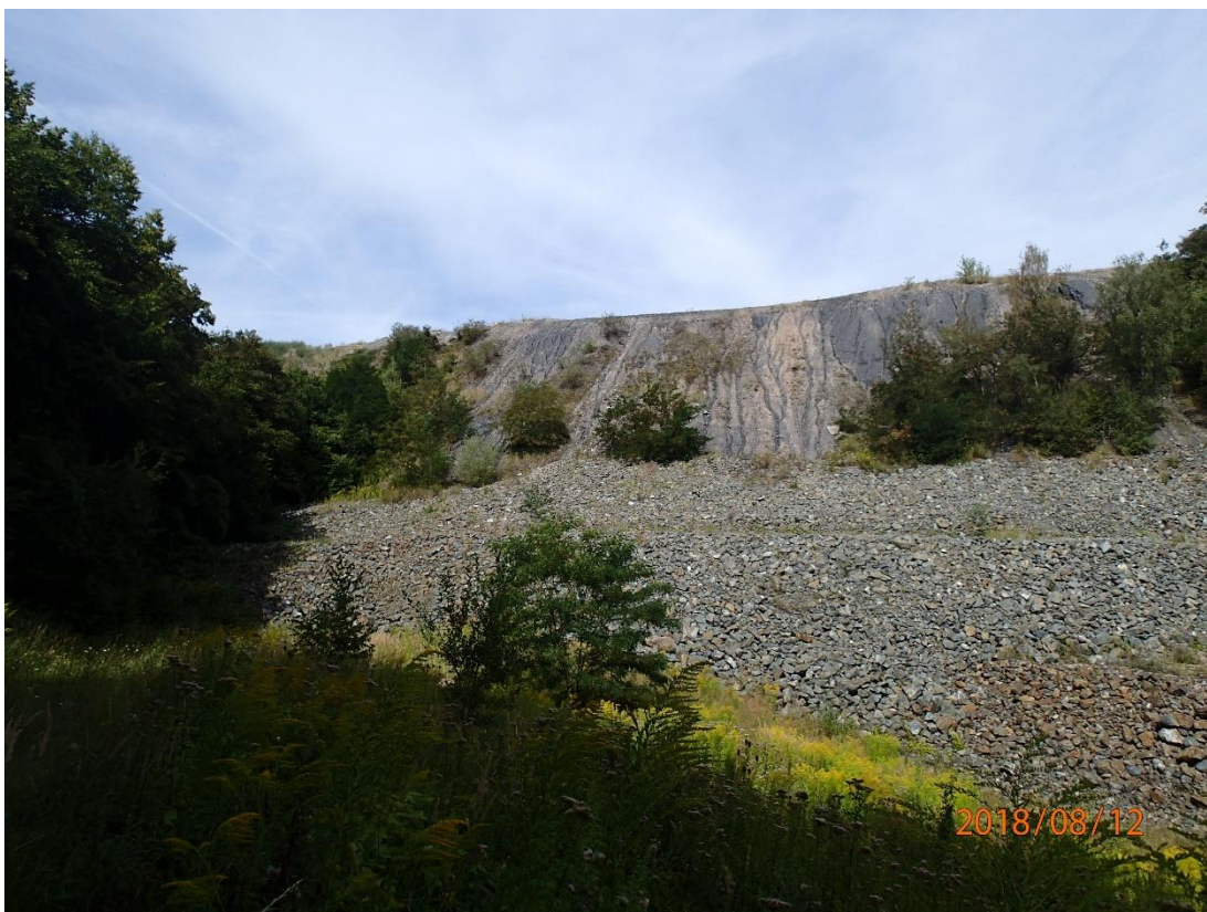
Foto č. 11 – halda Schoeller-starý odval, pohled od jihu. Zdroj: archiv autorky
