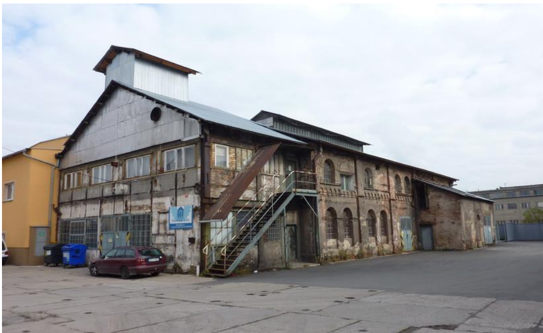
Obrázek č. 42 – Strojovna před rekonstrukcí. Zdroj: www.arxstudio.cz/kladno-vojteska-hut . [2019.03.27.]
