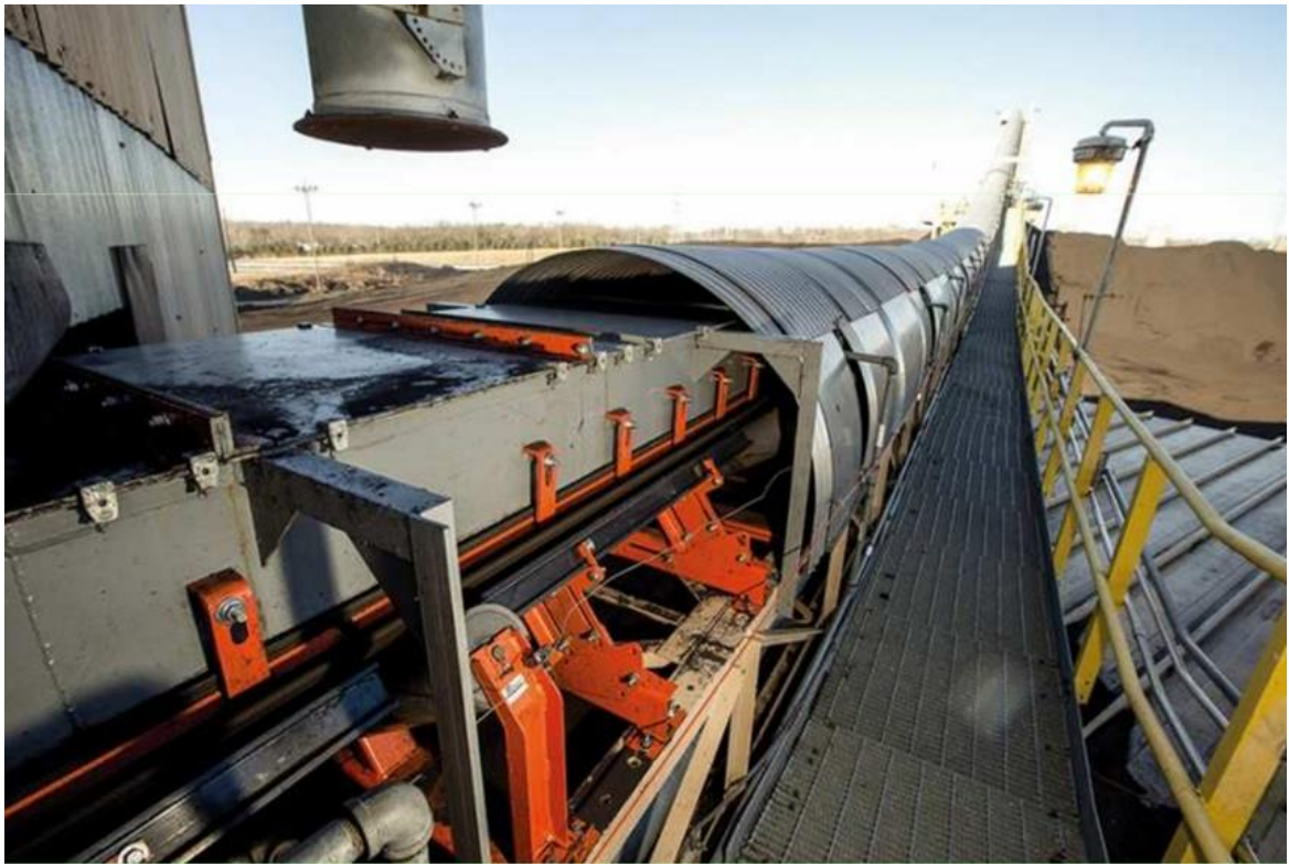
Obrázek 17: Ukázka pozemního pásového dopravníku.
