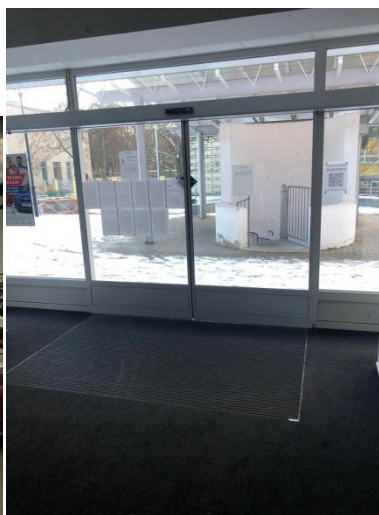
Obrázek 4. Hlavní vstup zevnitř.
