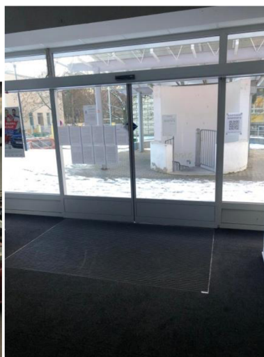
Obrázek 4. Hlavní vstup zevnitř.
