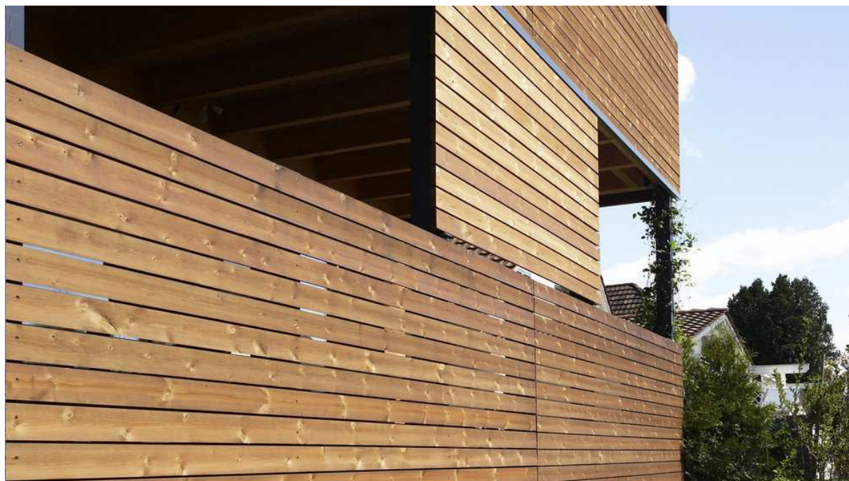
Obr. 25 Obklad z termodřeva
