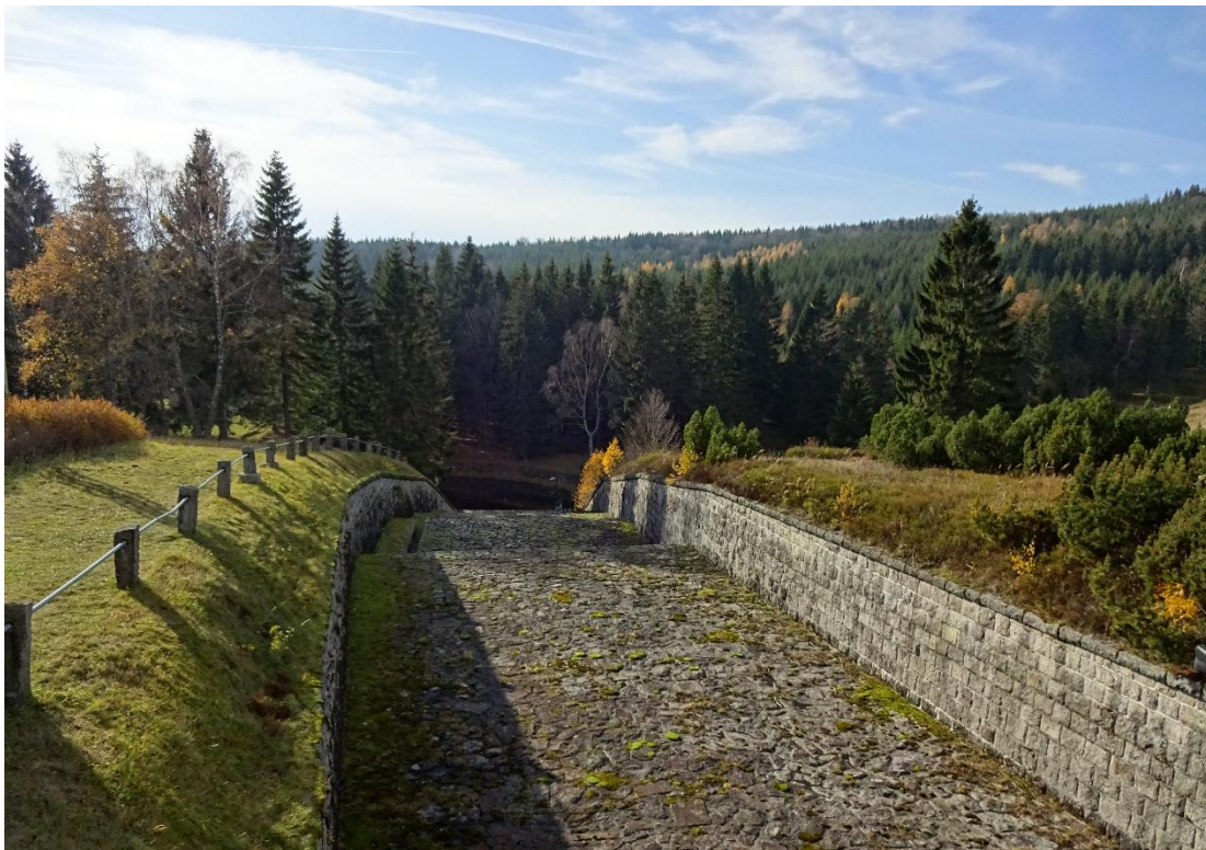
Příloha 4: Osmistupňový kaskádovitý bezpečnostní přeliv VD Souš. (foto Potměšil a Janů – 5. 11. 2018)
