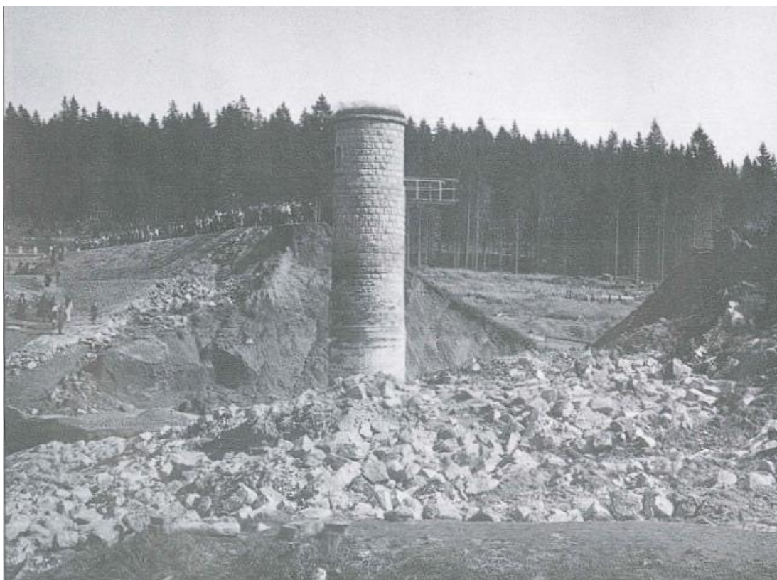
Příloha 17: Torzo hráze a šoupátková věž. Na následky katastrofy se chodilo podívat mnoho lidí. (Přehradý Čech, Moravy a Slezska, 2005)
