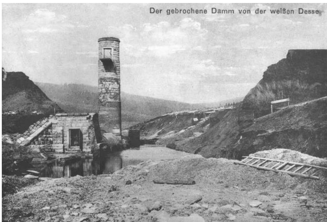
Příloha 18: Průrva v hrázi se šoupátkovou věží několik dní po katastrofě. (Přehradý Čech, Moravy a Slezska, 2005)
