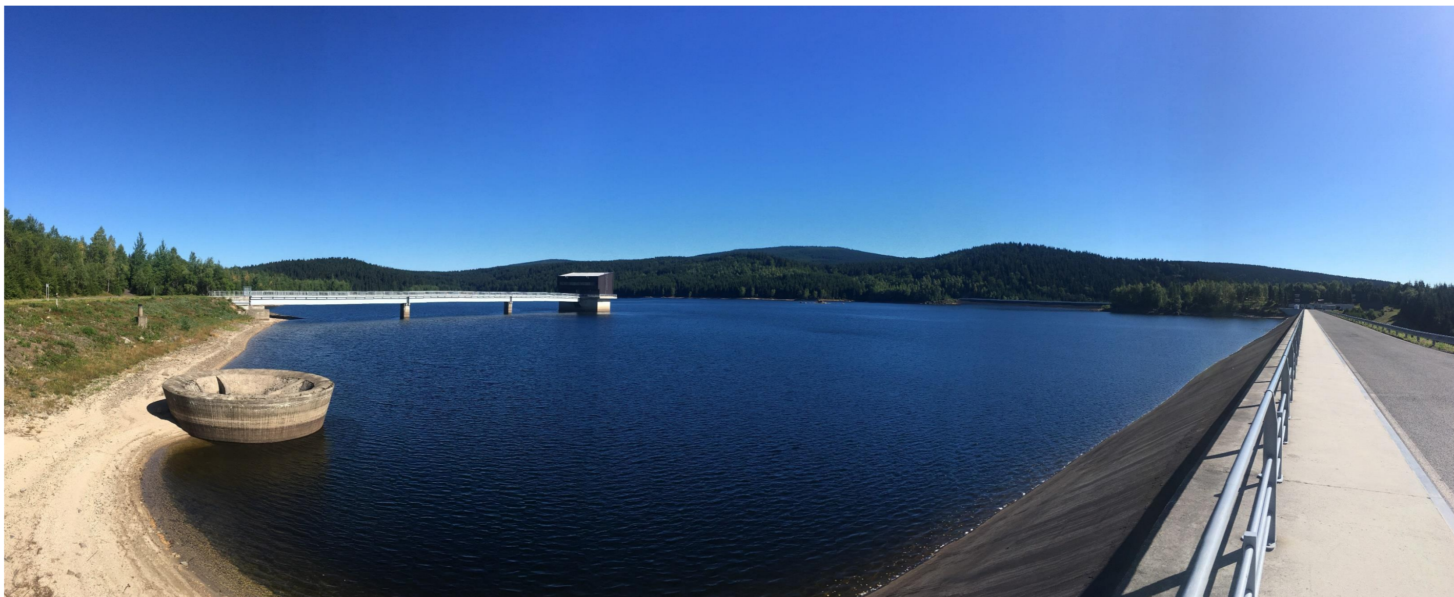
Příloha 7: Přehradní nádrž Josefův Důl. Vlevo je kašnový bezpečnostní přeliv. Za ním je situována přístupová lávka ke sdruženému odběrnému objektu. V pravé části fotografie je hlavní hráz, kde na návodní straně je použito asfaltobetonové těsnění. Na konci hlavní hráze se nachází provozní budovy. V pozadí lze vidět boční hráz. (foto autor – 6. 8. 2018)
