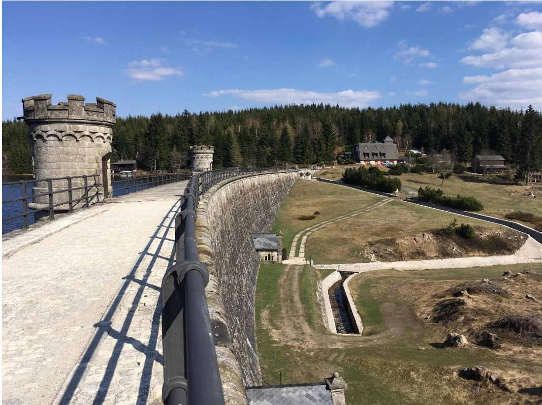
Příloha 1: VD Bedřichov. Hráz, provozní objekt, bezpečnostní přeliv, vývar. (foto autor - 18. 4. 2019)
