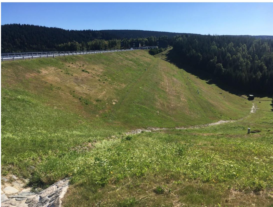
Příloha 9: Zatravněný vzdušný líc hlavní hráže v Josefově Dole. (foto autor – 6. 8. 2018)
