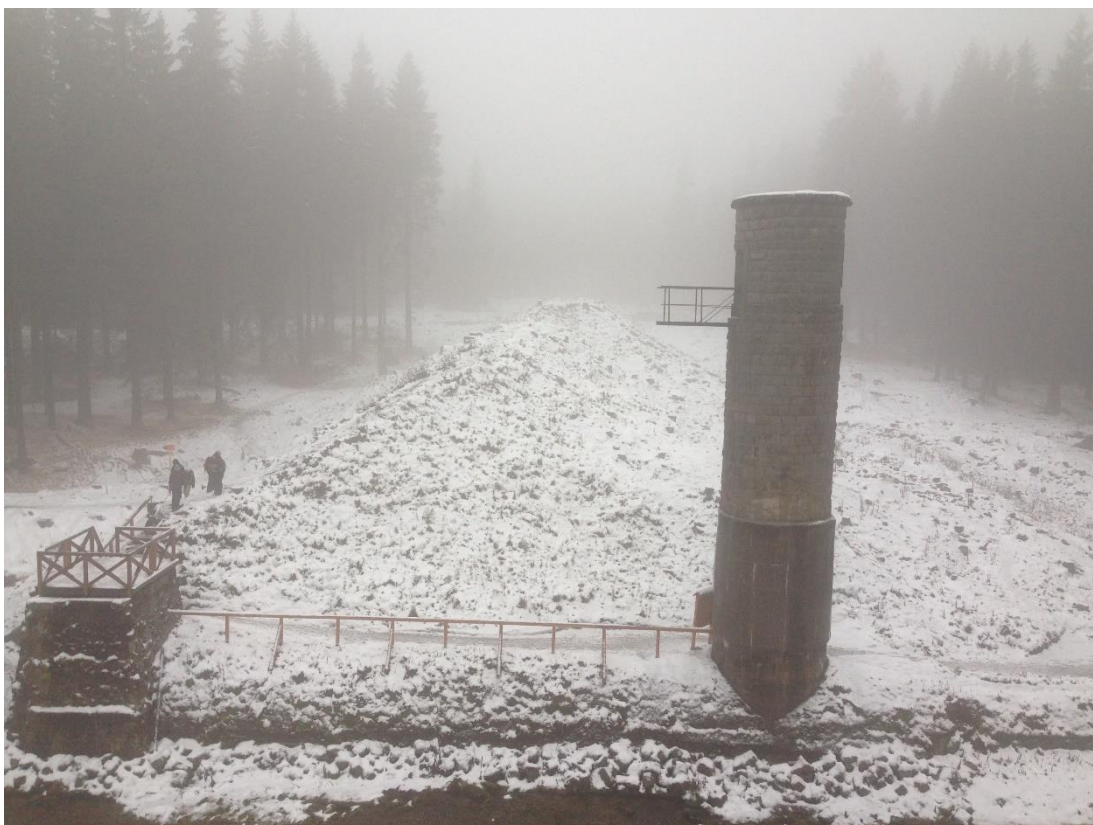
Příloha 21: Současný stav hráze a šoupátkové věže. (foto autor – 17. 11. 2016)
