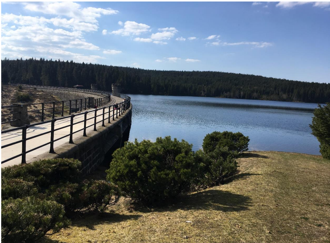
Příloha 2: Pohled na VD Bedřichov od provozní budovy hrázného. (foto autor - 18. 4. 2019)
