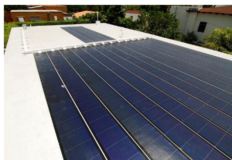
Obrázek 21 FV panel na bázi polykrystalického křemíku
