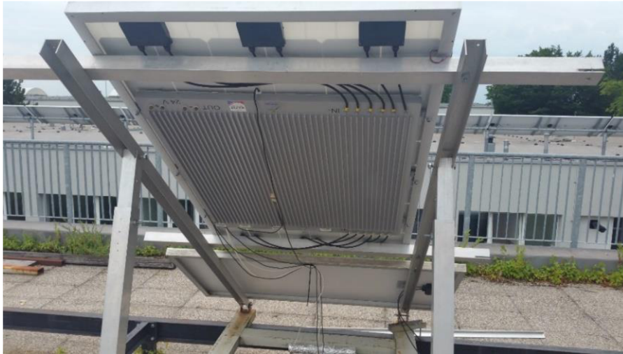
Obrázek 43 Fotovoltaický panel s integrovanými lithiovými akumulátory
