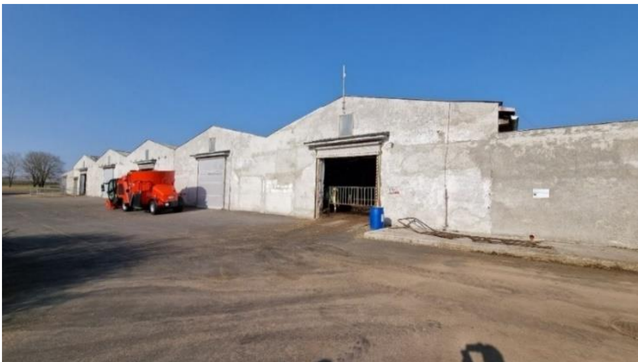
Obrázek 12. Původní stáj, venkovní pohled (foto autor, 2022)
