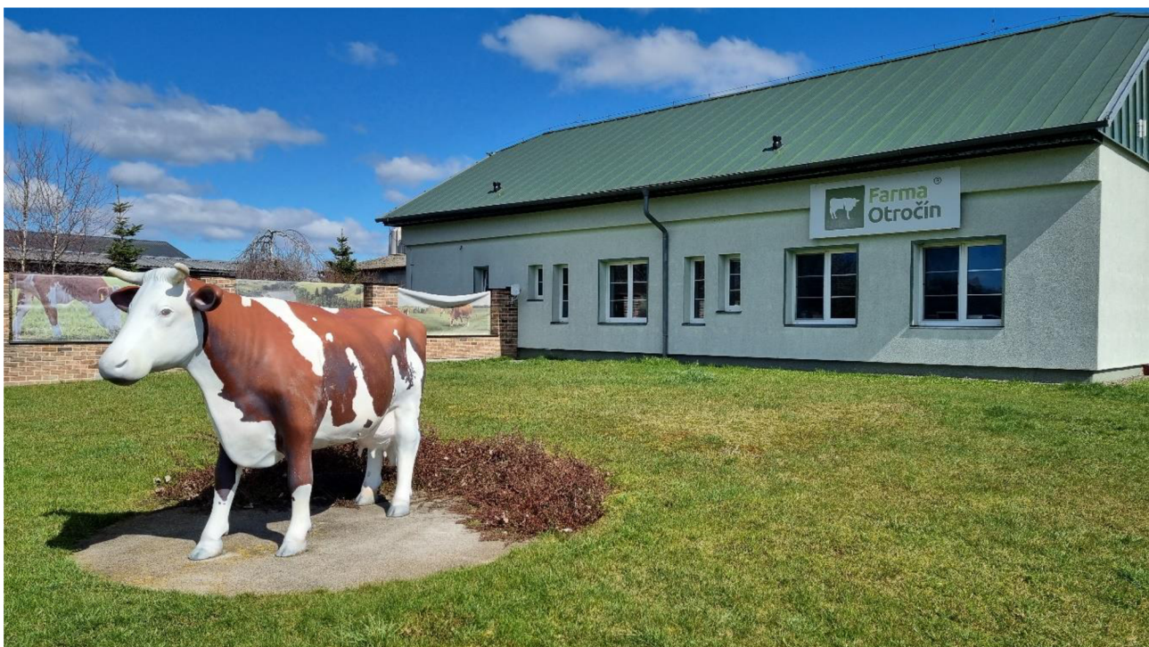
Obrázek 13. Administrativní budova u příjezdu na farmu (foto autor, 2023).
