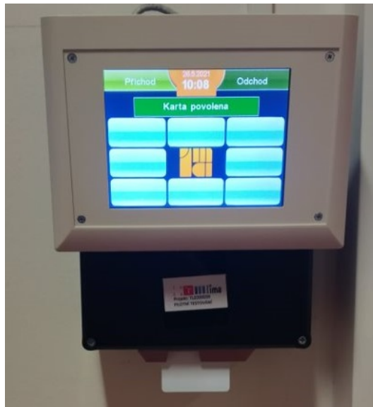
Obr. 6.3: Povolení přístupu při pilotním provozu
