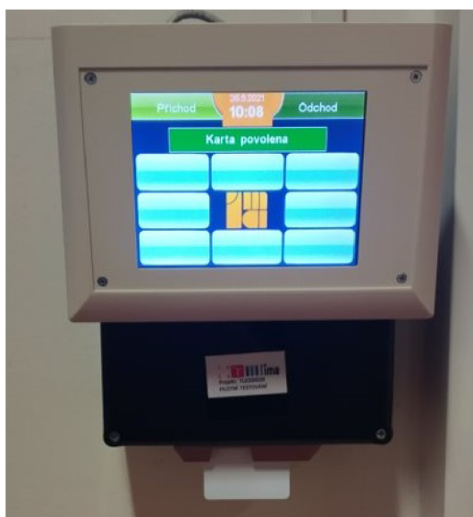
Obr. 6.3: Povolení přístupu při pilotním provozu
