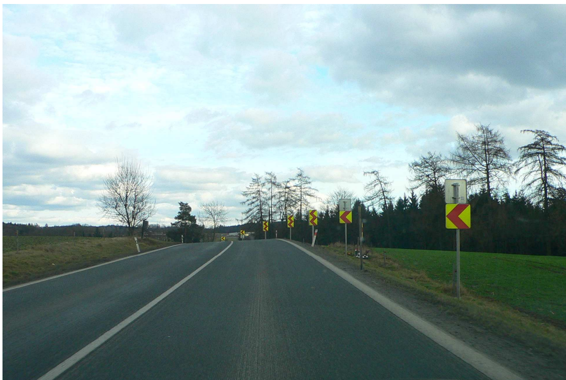
Příloha G - Stejný úsek silnice I. třídy č. 34, již osazen reflexními tabulemi
