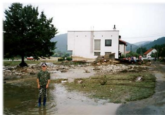
Obr. 10: Zaplavený Městys Štěpánov nad Svratkou při povodni v roce 2002 (Městys Štěpánov nad Svratkou ©2023)
