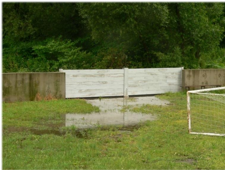
Obr. 36: Namontovaná mobilní stěna, při zvýšených průtocích řeky Sázavy, na fotbalovém stadioně ve Světlé n/S (MěÚ Světlá nad Sázavou 2013)
