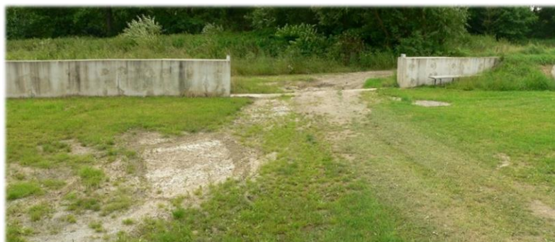
Obr. 37: Odmontovaná mobilní stěna Sázavy na fotbalovém stadioně ve Světlé n/S (MěÚ Světlá nad Sázavou 2013)
