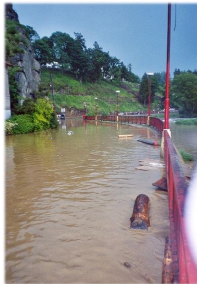
Obr. 12: Zaplavená pozemní komunikace vodou z Olešenského potoka v roce 2004 (MěÚ Světlá nad Sázavou 2004)
