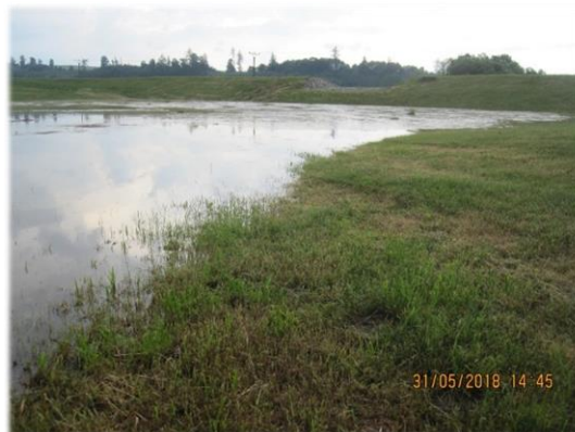
Obr. 33: Vzniklý poldr plnící svoji funkci při zvýšených průtocích dne 31.5.2018 (OÚ Příseka 2018)
