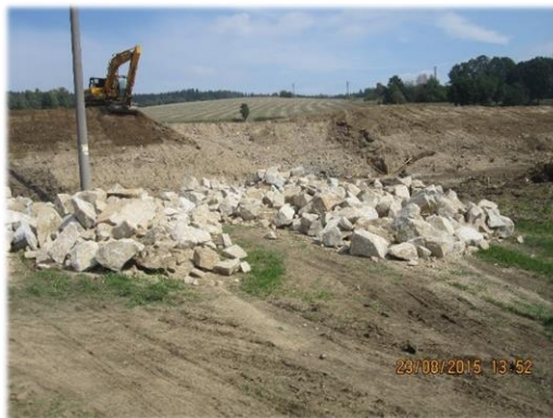
Obr. 30: Stavba hráže při realizaci PPO v obci Příseka. Fotografie pořízena při průběhu stavby dne 23.8.2015 (OÚ Příseka 2015)
