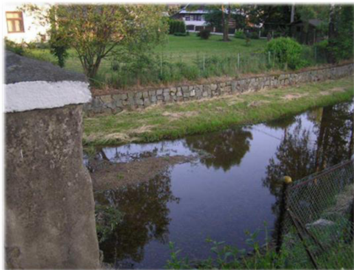
Obr. 27: Regulované koryto u historického mostu v Herálci. V této části se ukládají splaveniny (Šindlar s.r.o. 2015)
