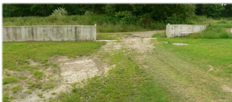
Obr. 37: Odmontovaná mobilní stěna Sázavy na fotbalovém stadioně ve Světlé n/S (MěÚ Světlá nad Sázavou 2013)
