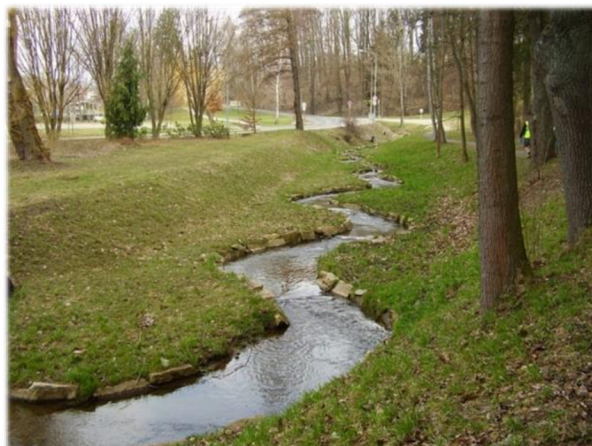
Obr. 22: Obnovený meandrující tok v rámci přírodě blízkého protipovodňového opatření na Cihlářském potoce v Havlíčkově Brodě (Chládek a Tintěra Havlíčkův Brod, a.s. ©nepublikováno)
