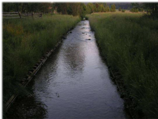
Obr. 28: Regulované a opevněné koryto nad Herálcem (Šindlar s.r.o. 2015)
