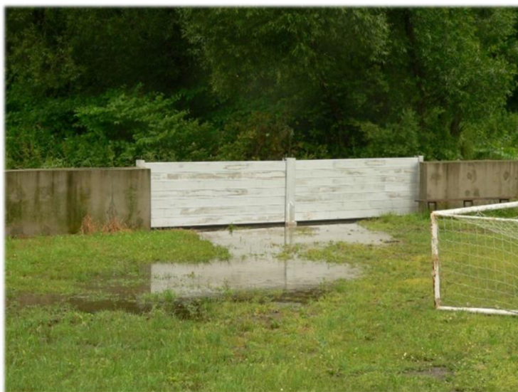
Obr. 36: Namontovaná mobilní stěna, při zvýšených průtocích řeky Sázavy, na fotbalovém stadioně ve Světlé n/S (MěÚ Světlá nad Sázavou 2013)
