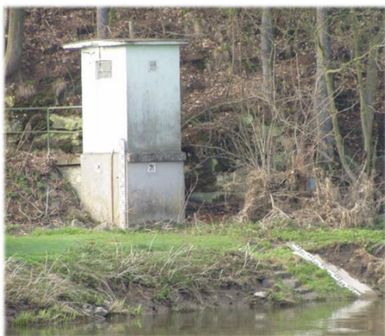
Obr. 16: Limnigrafická stanice s kombinovanou vodočetnou latí při běžném průtoku. Vodočet Světlá nad Sázavou (MěÚ Světlá nad Sázavou 2006)
