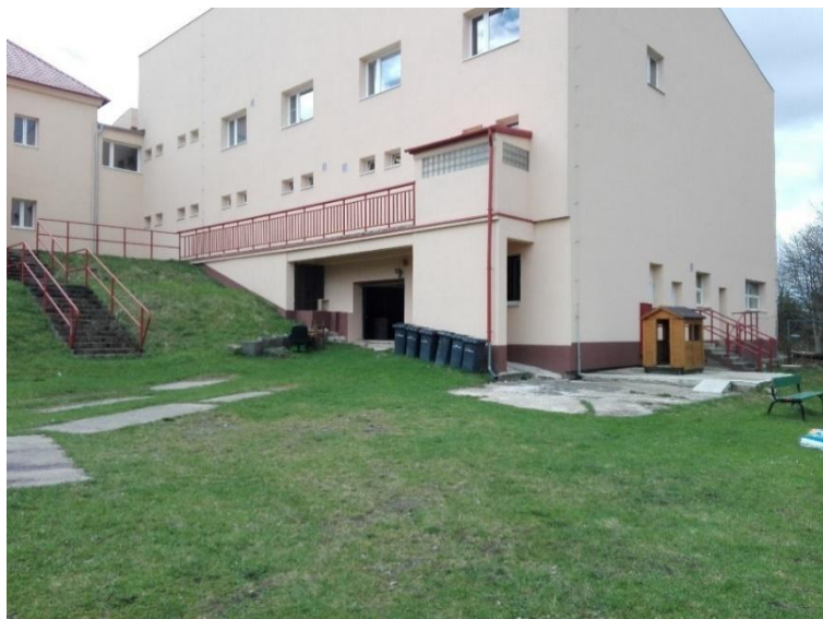
Obrázek 5: Svažitá část s nebezpečným schodištěm, vlastní tvorba 27. 10. 2017, HSK
