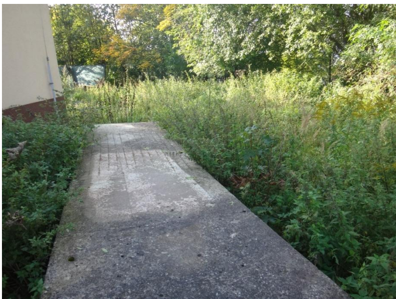
Obrázek 7: Nepřístupná část s betonovými bloky, vlastní tvorba 27. 10, 2017, HSK
