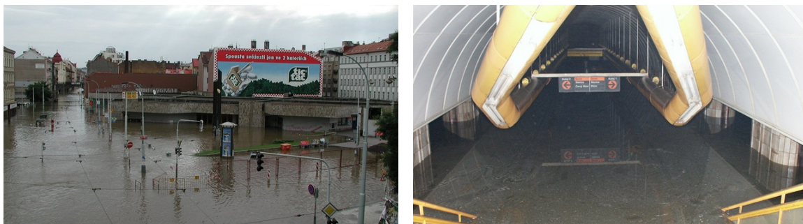
Obrázek č. 5, 6: Zatopená stanice metra B Florenc
