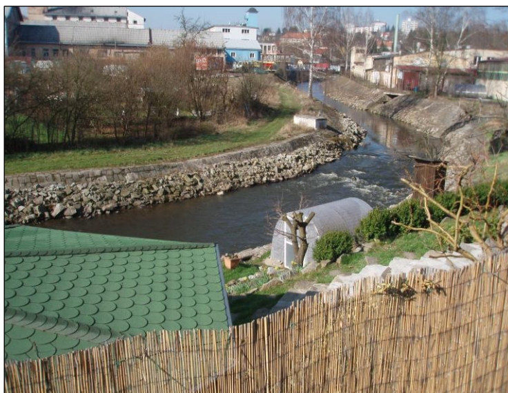
Obr. 12: Část zpevněného koryta v osadě VY10.D.2. Jihlava CHAAZ nádraží Zdroj: Nováková (2014)
