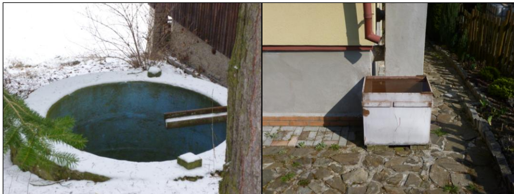
Obr. 28: Nádrž na svod dešťové vody v VY10.P.1. Brtnice – CHAAZR nad Rychlovským r. Zdroj: Nováková (2013)
