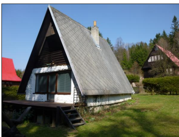
Obr. 3: Stanová střecha v CHO VY10.L.1. Batelov u Pilského r.
