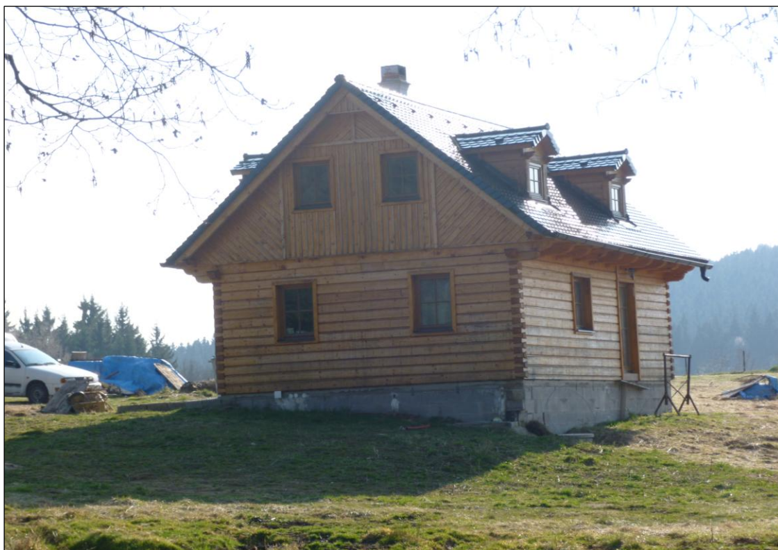
Obr. 27: Rekreační domek v osadě VY7.M.6. Hutě - Dolní Čeřínek; zkolaudovaný jako hospodářská budova. Zdroj: Nováková (2012)
