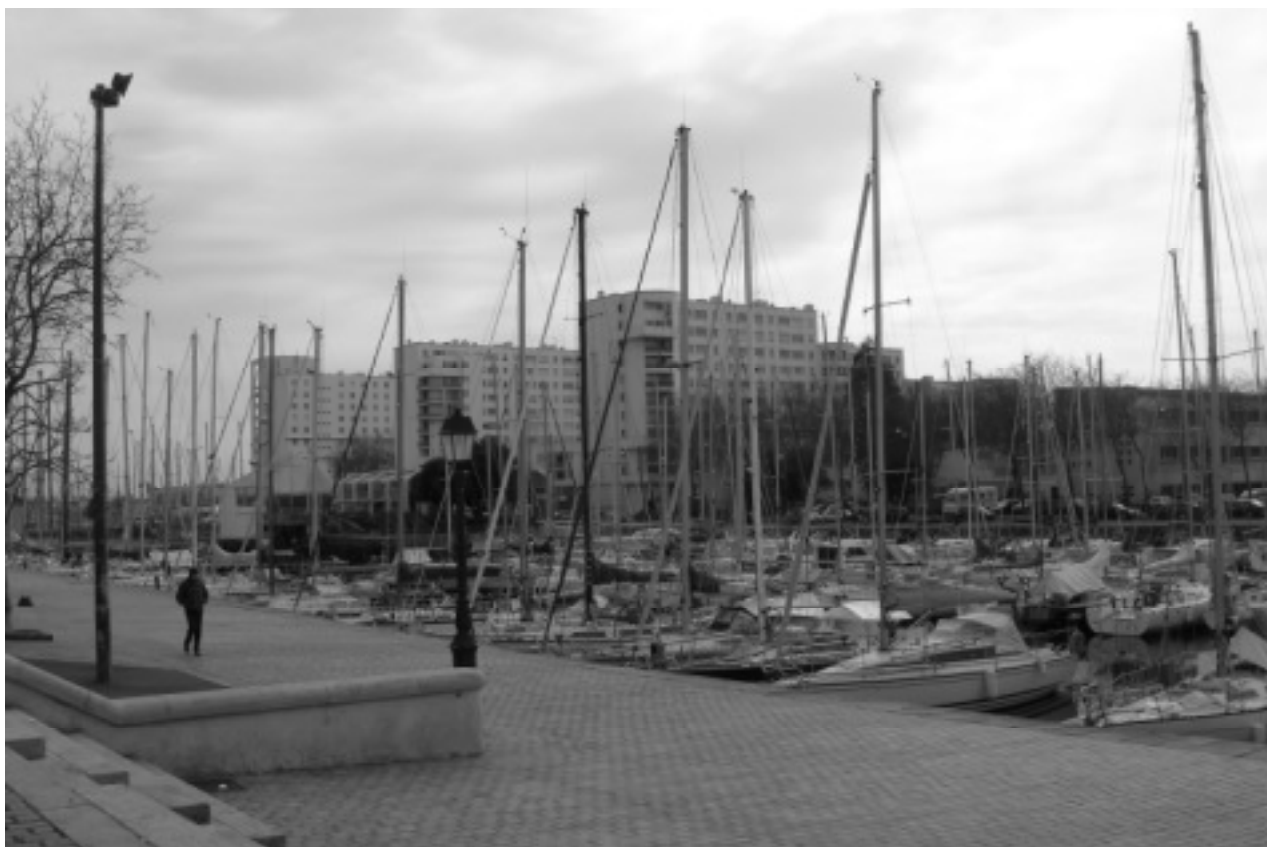
Obr.49 – Rehabilitace obytného bloku na nábřeží Rohan
