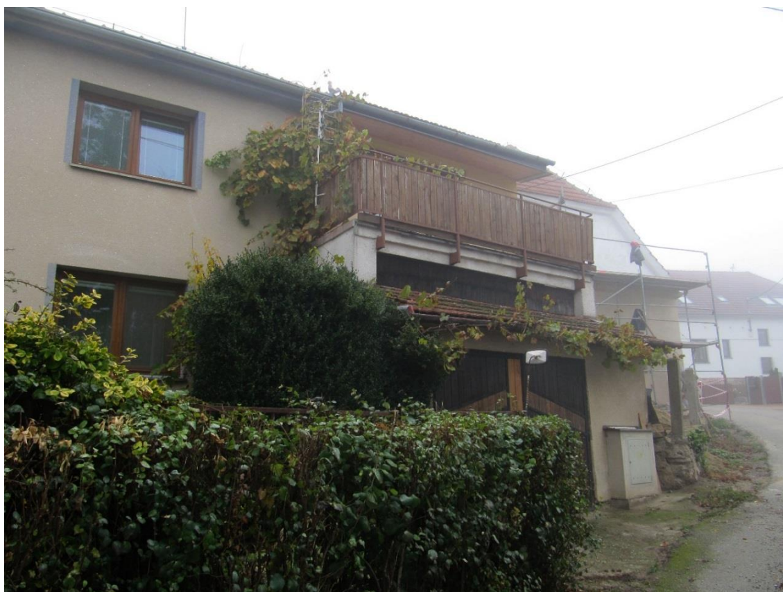
Obr. 36 – Stavba ve svých rozích obrostlá popínavou vegetací; zdroj: vlastní foto autorky
