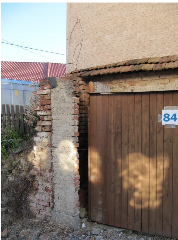
Obr. 32 – K budově přiléhající kusy obnažených zdí; zdroj: vlastní foto autorky
