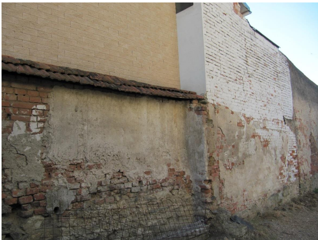
Obr. 31 – Komplikované rozhraní budov; zdroj: vlastní foto autorky
