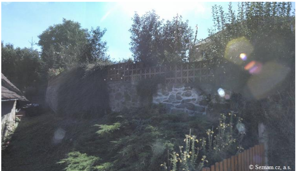
Obr. 58 – Foto zmiňované zdi mezi parcelami p. č. 541 a 542/2; zdroj: [34]
