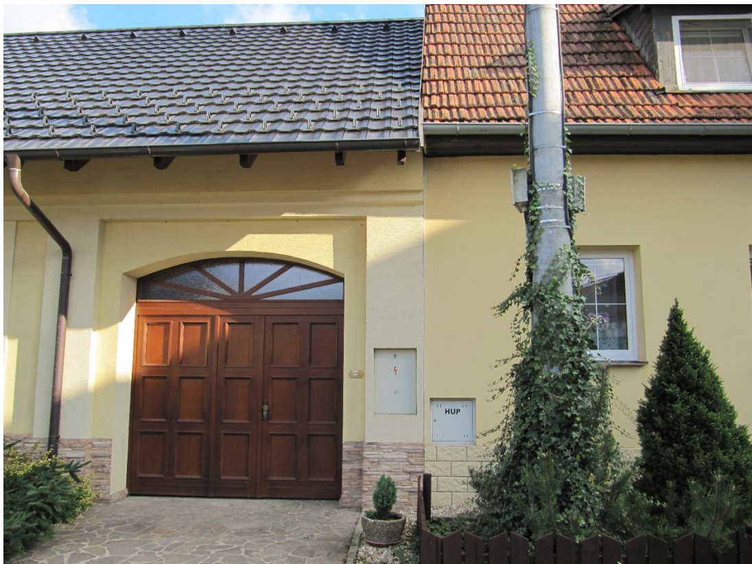
Obr. 27 – Přiléhající zdi sousedících budov různých vlastníků; zdroj: vlastní foto autorky
