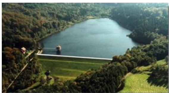
Obrázek 32: Vodní dílo Chřibská Zdroj: Povodí Ohře, 2019
