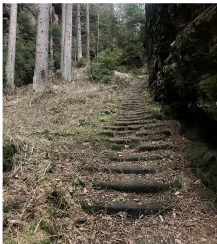
Obrázek 18: Schody vedoucí Kostelní cestou (Foto: P. Živná, únor 2022)
