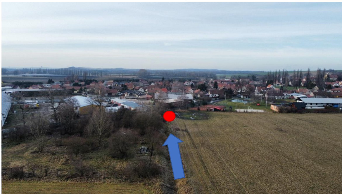
Obrázek 33: Pohled na KB ohrožené obce Čečelice.
