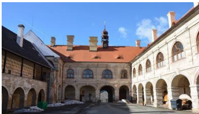
Zámek Rataje nad Sázavou (pohled od východu)
