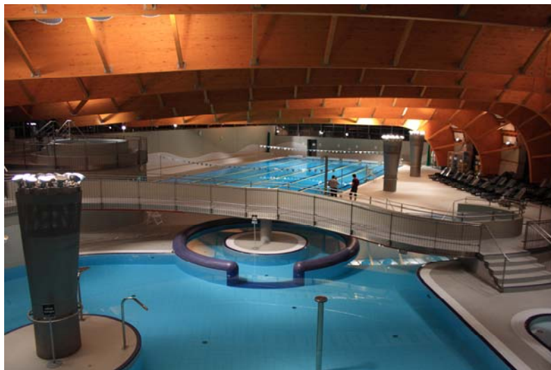
Obr. 10 Pohled zevnitř bazénové haly
