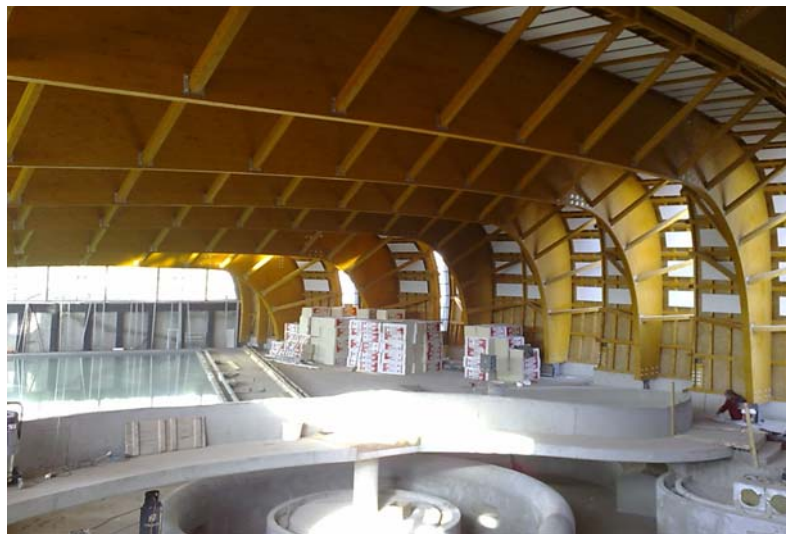
Obr. 9 Pohled zevnitř bazénové haly před dokončením
