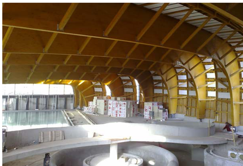
Obr. 9 Pohled zevnitř bazénové haly před dokončením
