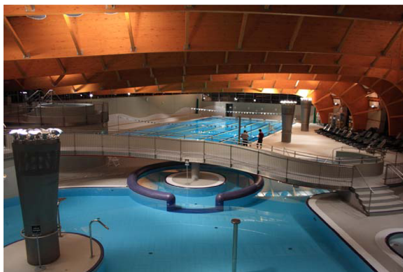
Obr. 10 Pohled zevnitř bazénové haly
