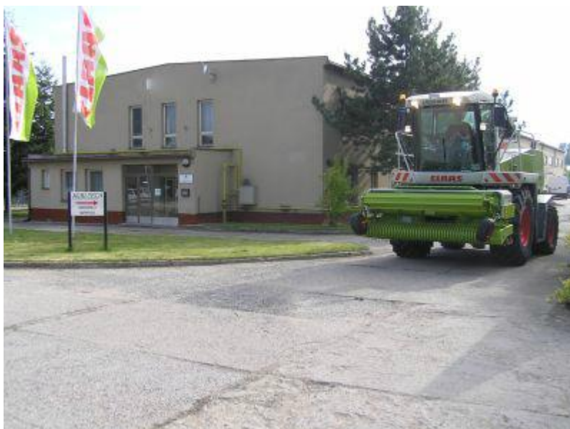
Obrázek č. 4 Pohled na aktuální průčelí hlavní budovy
