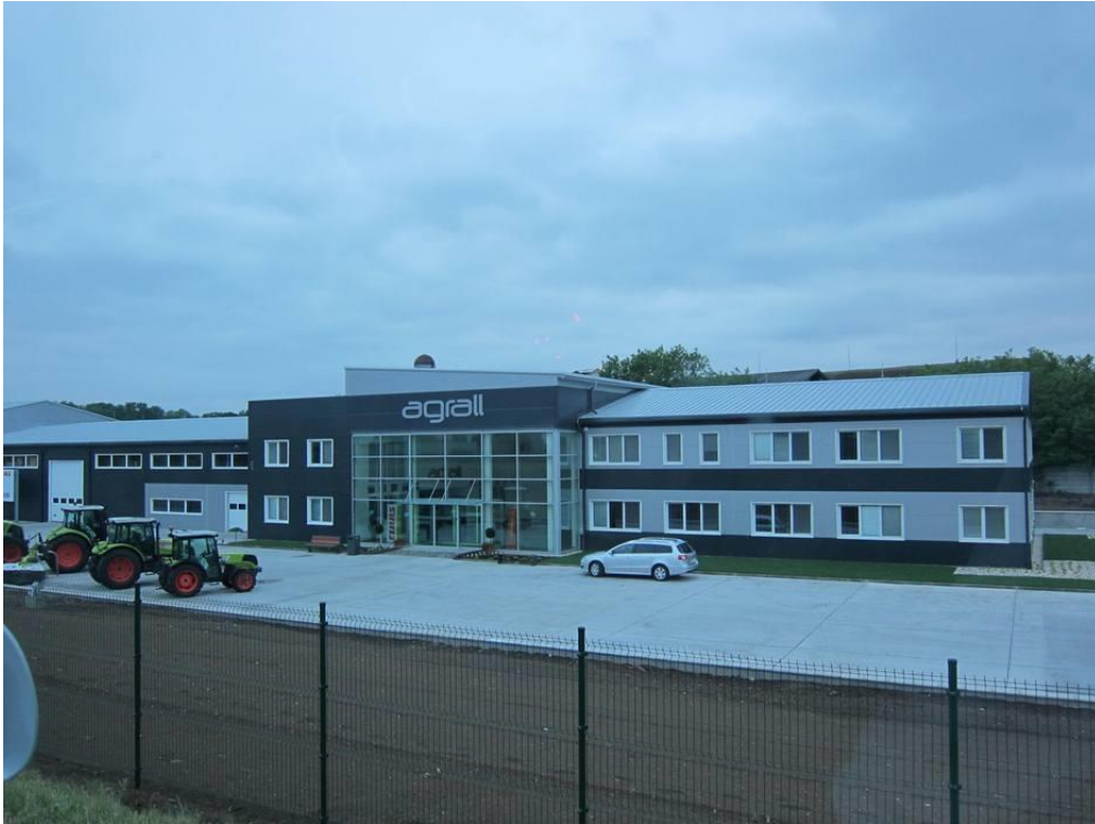
Obrázek č. 15 Pohled na již realizovaný návrh budov sesterské pobočky naší firmy
