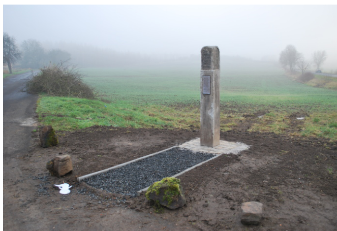
Obrázek č. 38: Obnovený milník na žichlickém rozcestí (JEŘÁBEK, 2017)
