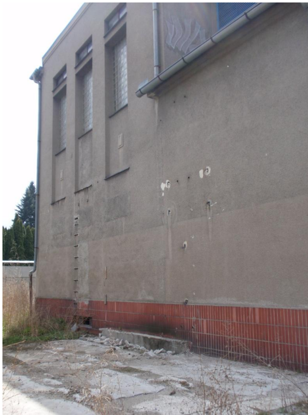
Obr. 3: Pohled na zadní stěnu objektu
