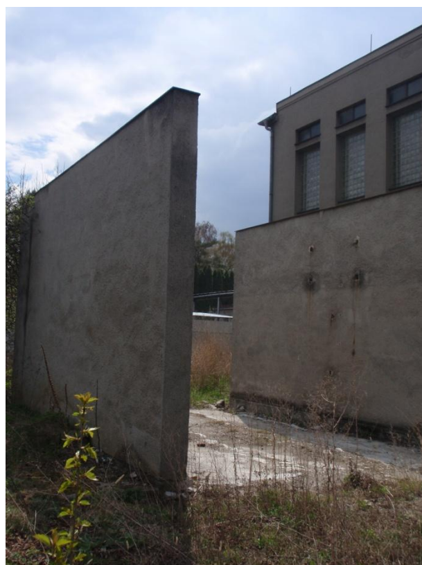
Obr. 4: Stěna původně nesoucí dráty vysokého napětí
