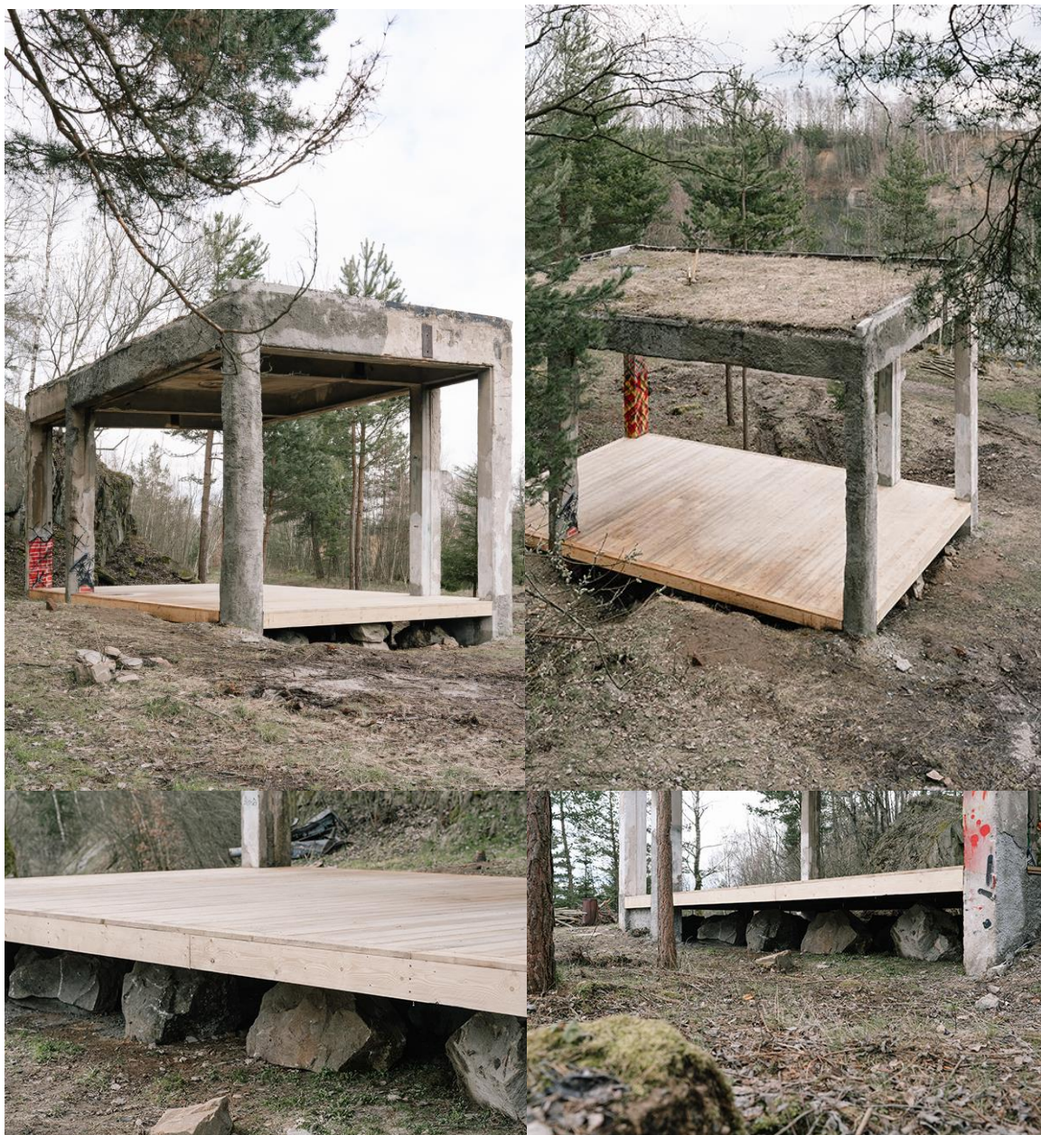
Drtička kamene, Horní Cerekev - momentální stav, 16. 4. 2023, beton, ocel, dřevo, rozměry 4500 x 5200 x 8200 mm
