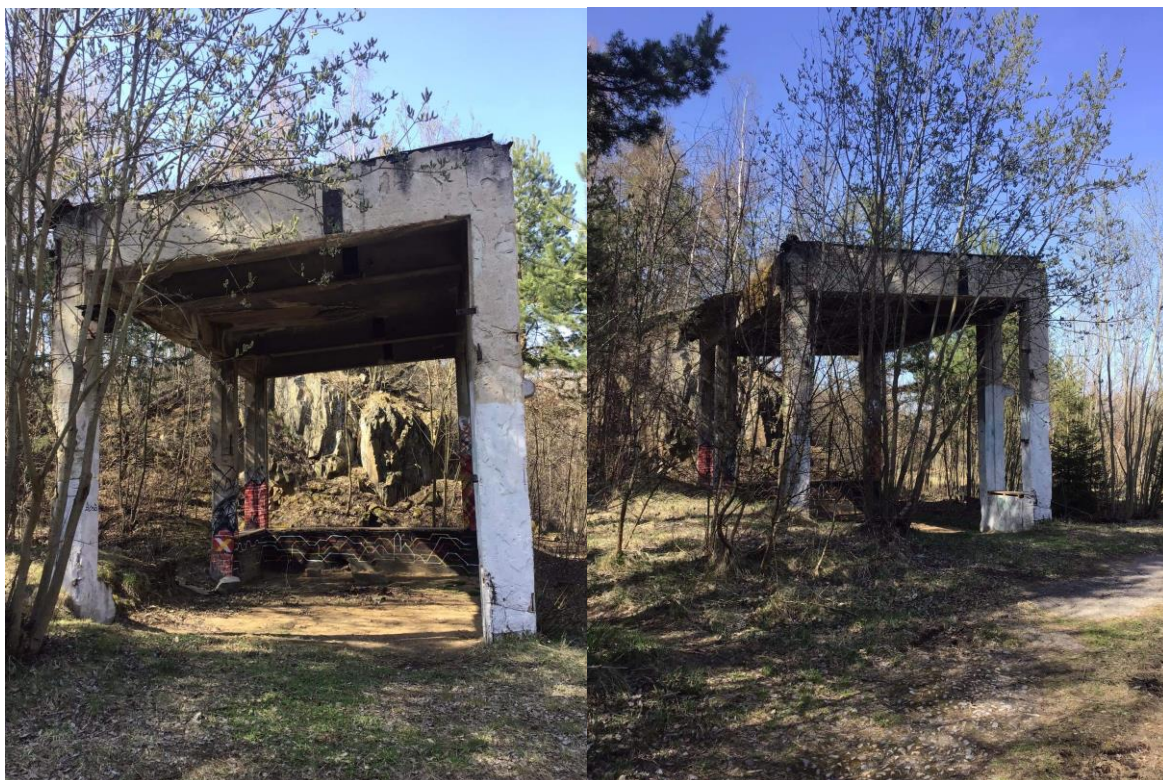
Drtička kamene, Horní Cerekev -původní stav, 2023, beton, ocel, rozměry 4500 x 5200 x 8200 mm
