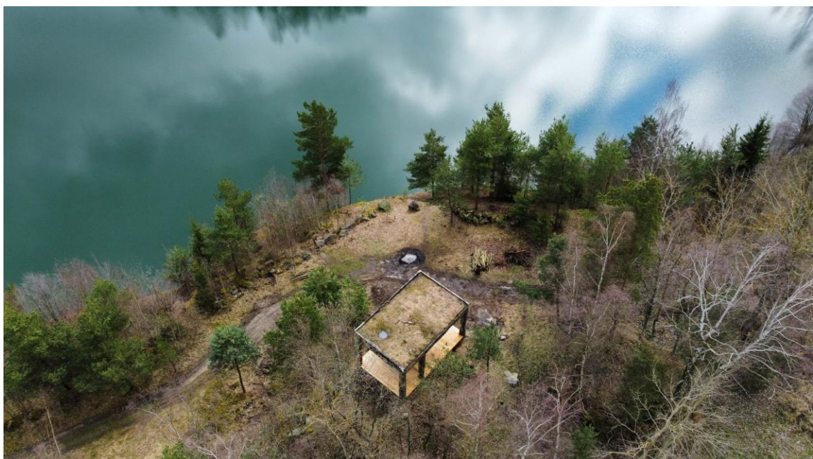
Drtička kamene, Lom Horní Cerekev-momentální stav, 16. 4. 2023, beton, ocel, dřevo, rozměry 4500 x 5200 x 8200 mm
