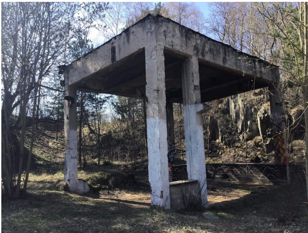
Drtička kamene, Horní Cerekev -původní stav, 2023, beton, ocel, rozměry 4500 x 5200 x 8200 mm
