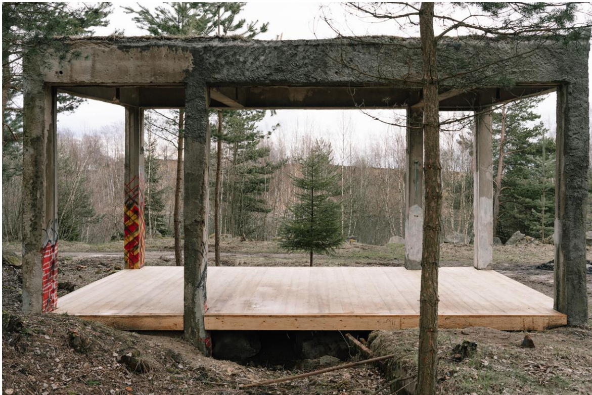
Drtička kamene, Horní Cerekev - momentální stav, 16. 4. 2023, beton, ocel, dřevo, rozměry 4500 x 5200 x 8200 mm
