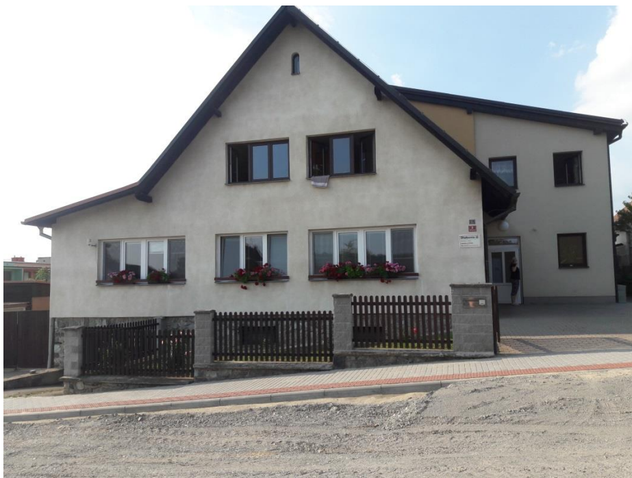
a) Budova Chráněného bydlení Letovice
