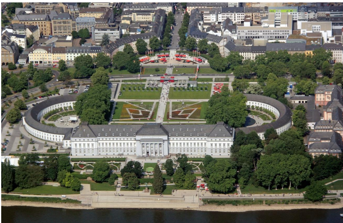
68. Koblenz, kurfiřtřská rezidence, pohled od severovřchodu.
