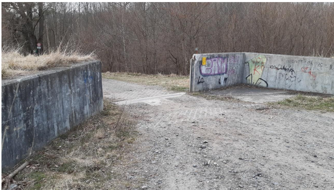
Obr. 37 Prostup v hrázi ZL 2043 u Atletického stadionu v Otrokovicích – březen 2022
