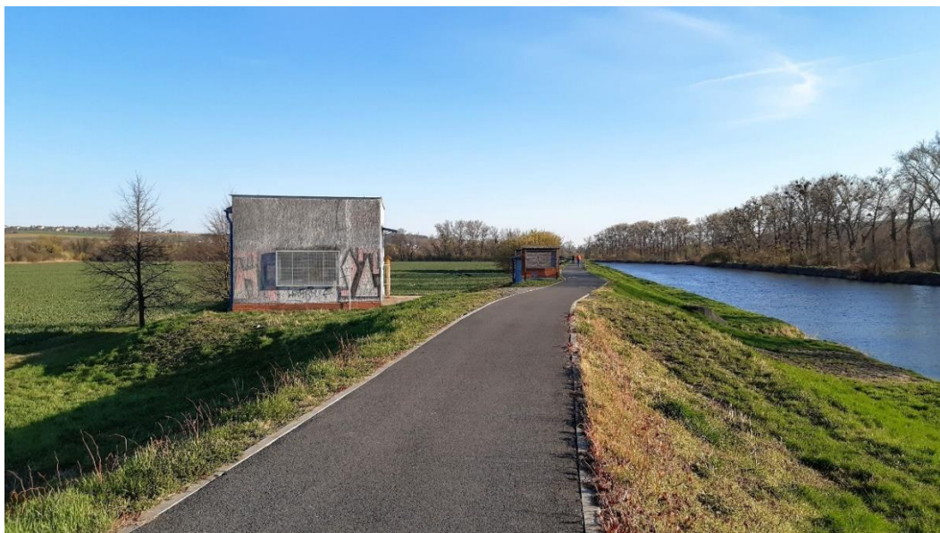
Obr. 41 Přečerpávací stanice dešťových vod u Moravy (za letištěm) SO 131/K – duben 2022
