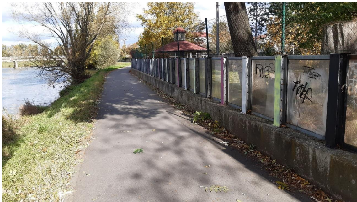
Obr. 35 Skleněná část hráze ZL 2049 v Napajedlích jižně od mostu na ulici Svatoplukova – říjen 2021
