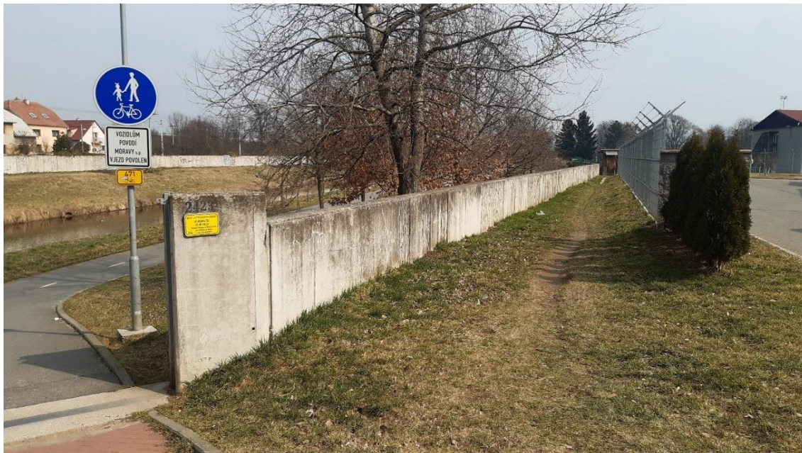
Obr. 33 Sypaná hráz s betonovou korunou ZL 2048 u požární stanice Otrokovice – březen 2022
