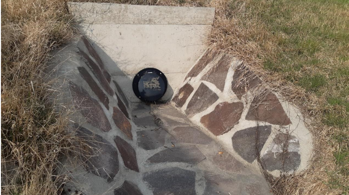
Obr. 39 Vyústění dešťové kanalizace s „klapkou“ pod hrází ZL 2043 u Staré Kolonie v Otrokovicích – březen 2022
