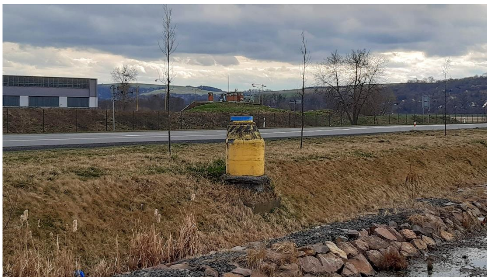
Obr. 40 Zvýšený kanalizační vstup dešťové kanalizace Continental Barum s.r.o. Otrokovice - duben 2022
