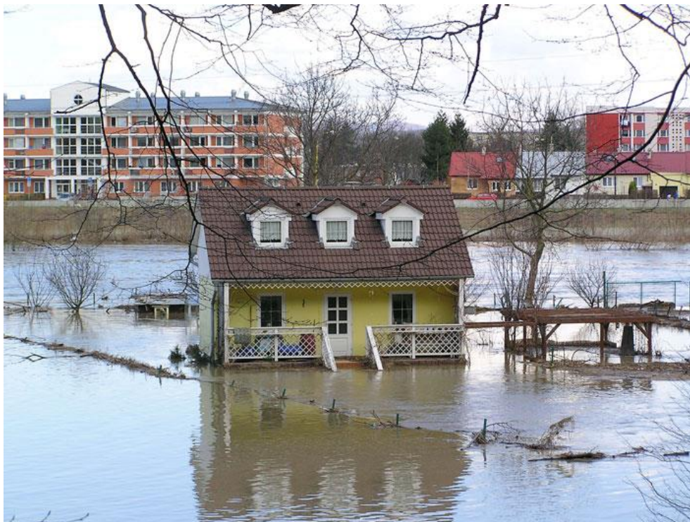
Obr. 16 Zaplavený dům v katastru obce Bělov, březen - duben 2006 (Přecechtěl, 2006)
