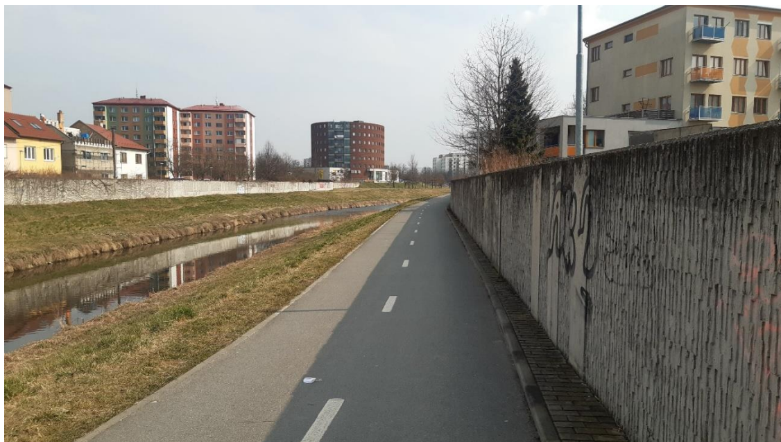
Obr. 36 Betonová hráz ZL 2233 u sídla Celní správy v Otrokovicích – březen 2022
