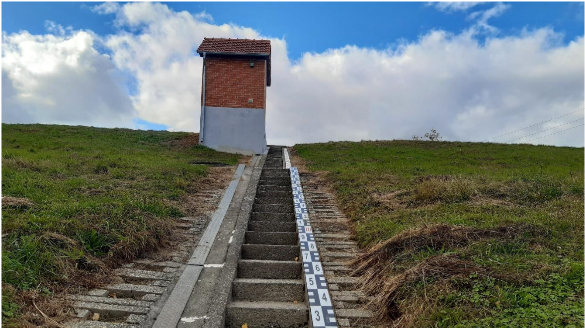
Obr. 3 Vodoměrná stanice ve Spytihněvi – říjen 2021
