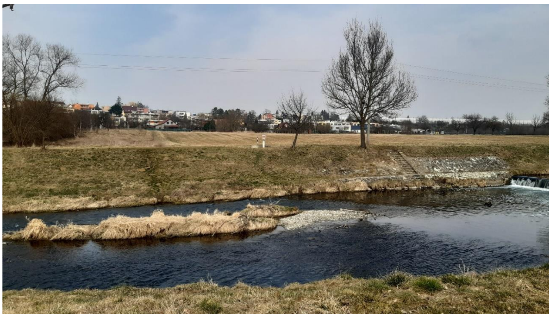
Obr. 32 Hráz ZL 2308, pohled na oblast Laziště – březen 2022
