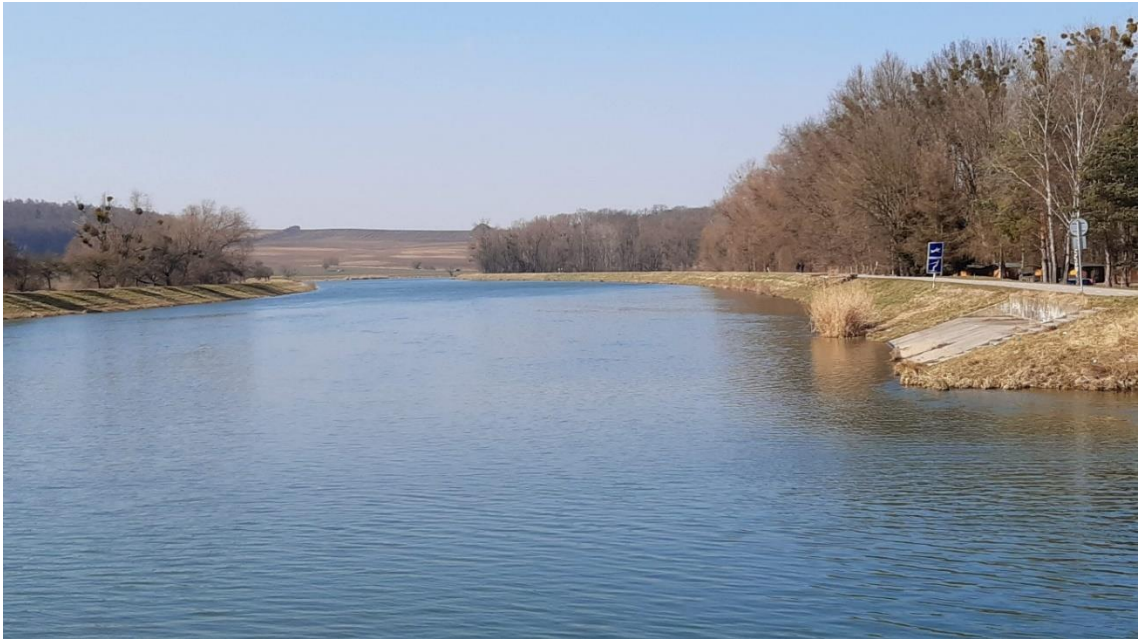
Obr. 31 Hráz ZL 2225 v úseku jez Bělov, březen 2021
