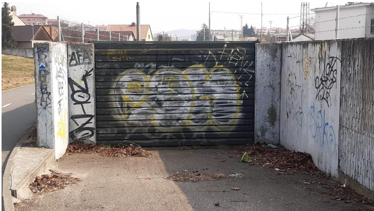
Obr. 38 Prostup s výdřevou v hrázi ZL 2234 u společnosti Pipelife Czech s.r.o. v Otrokovicích – březen 2022
