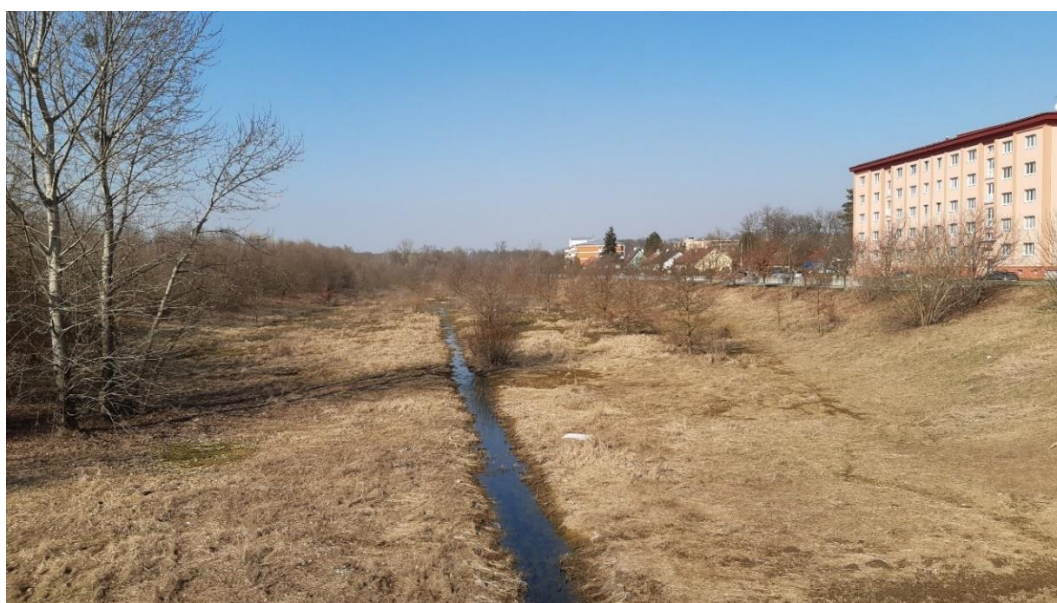
Obr. 42 Odlehčovací koryto řeky Moravy v úseku Bařov – Bahňák s betonovou zdí, březen 2021
