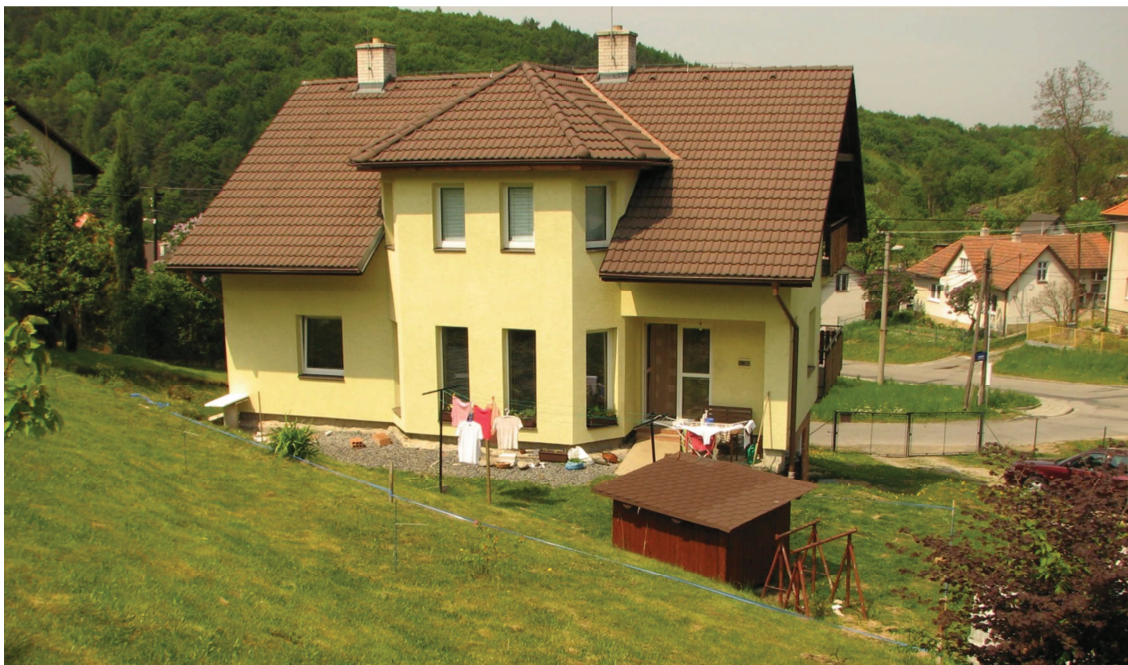
Obrázek 6: Fotodokumentace, pohled na jižní fasádu
