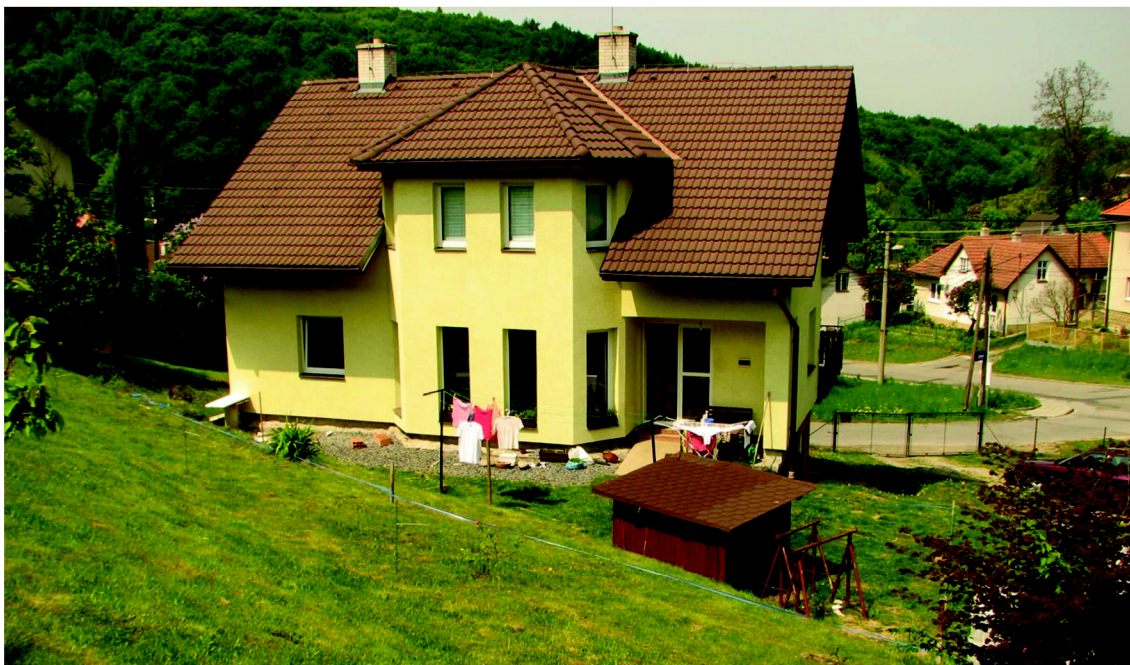
Obrázek 6: Fotodokumentace, pohled na jižní fasádu
