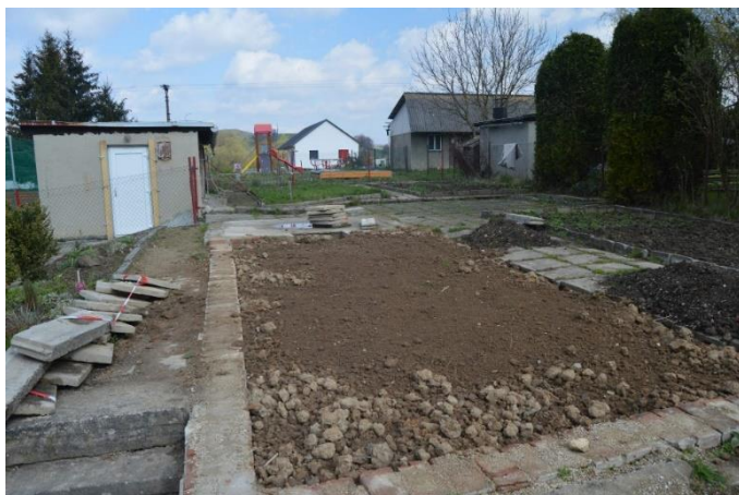
Obrázek 13. Aktuální stav školního pozemku – záhon po odstranění skleníku (ZŠ Hradišín). Foto autor.
