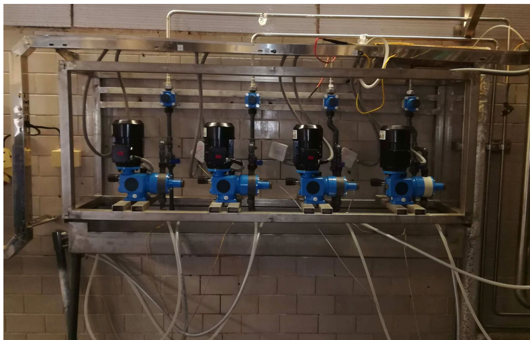
Obr. 6.4: Zapojení všech čerpadel do technologického celku
