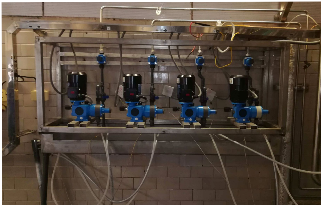
Obr. 6.4: Zapojení všech čerpadel do technologického celku
